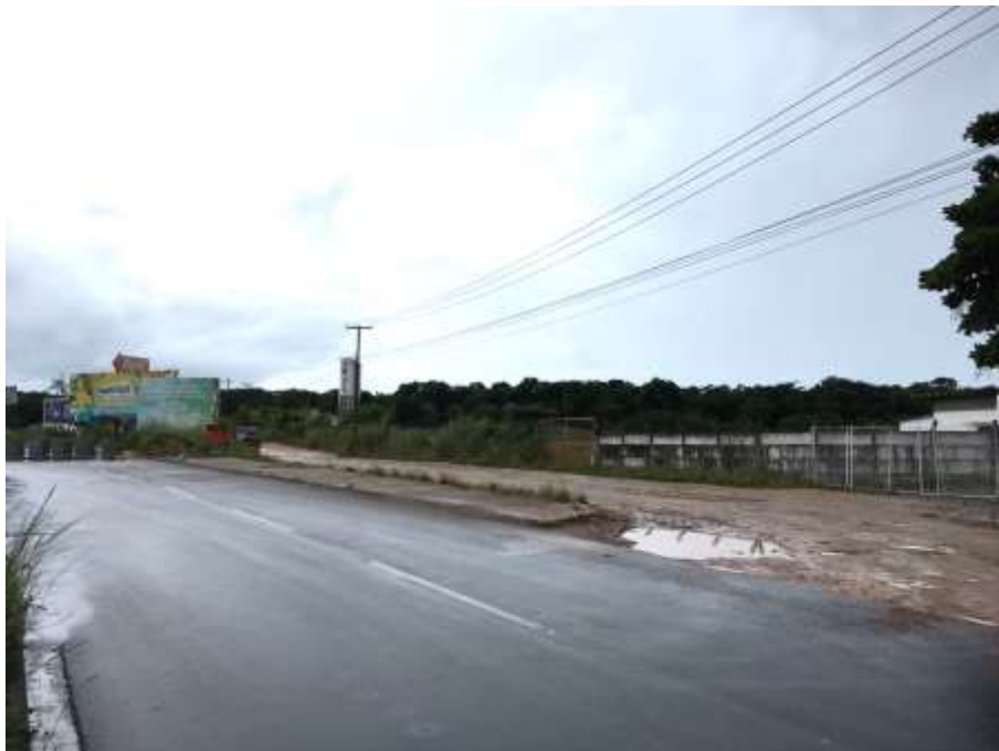
Via marginal à Rodovia BR-101 com imóvel à direita
