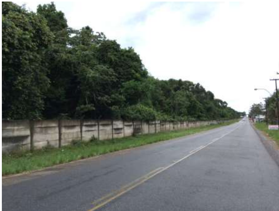
Acesso secundário ao imóvel – Est. Catre
