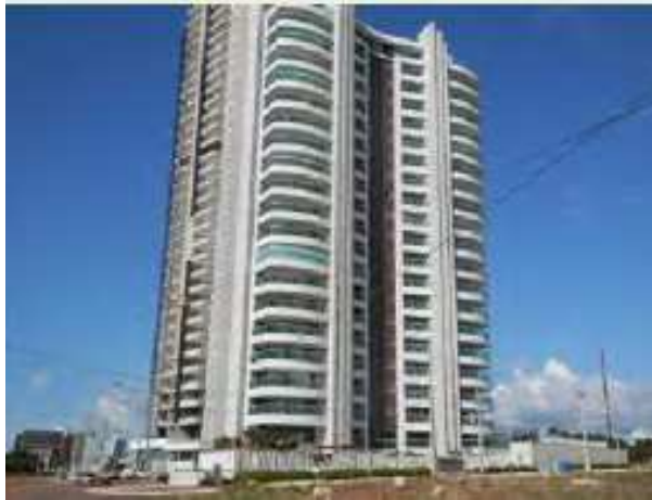
1: Vista da fachada do edifício.
