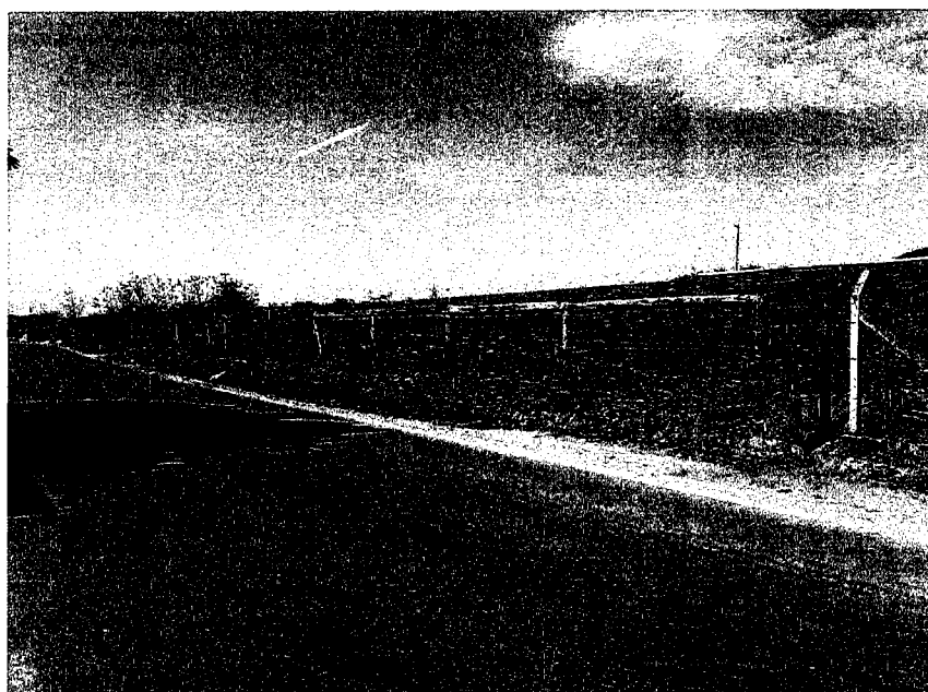
Vista da Área de empréstimo Jazida 01 (Sentido Rodovia MG-290)
