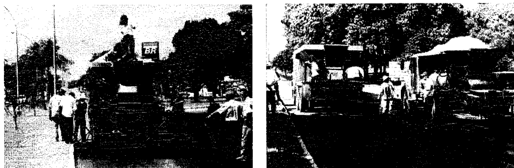
Figura 4.14 Exemplo de aplicação de lama asfáltica em um trecho de via urbana (Fotos: BR Distribuidora)
