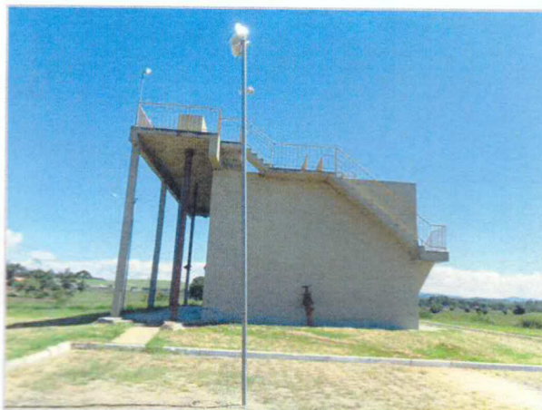
Foto 3. Estação de Tratamento de Esgoto Cidade Jardim – Reator UASB
