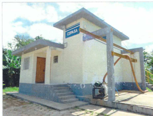
Foto 10. Estação elevatória de esgoto Sapucaí
