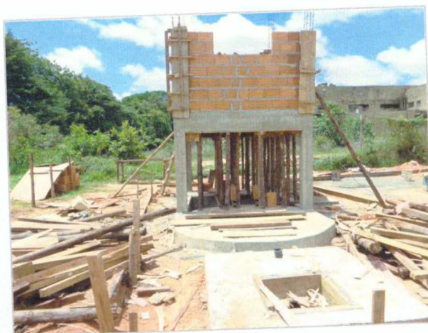
Foto 20. Obra da estação elevatória Faisqueira
