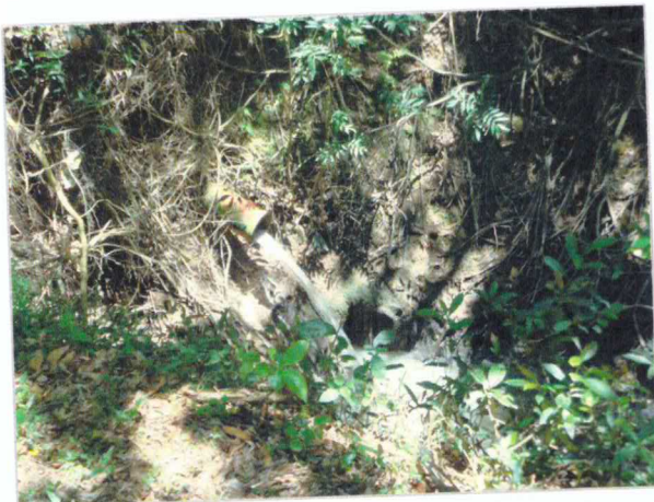
Foto 19. Lançamento de esgoto "in natura" no bairro Faisqueira
