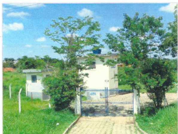
Foto 11. Estação elevatória de esgoto Ayrton Senna
