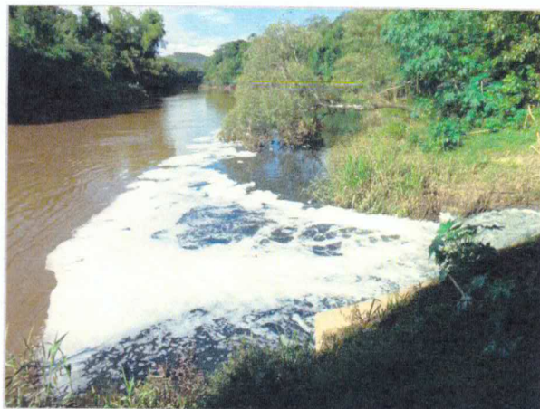
Foto 6. Ponto de lançamento de efluente tratado da ETE Sapucaí Mirim
