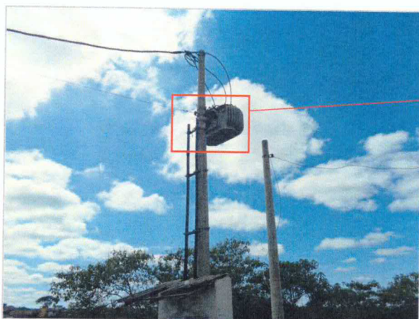
Foto 13. Estação elevatória – sistema de drenagem
