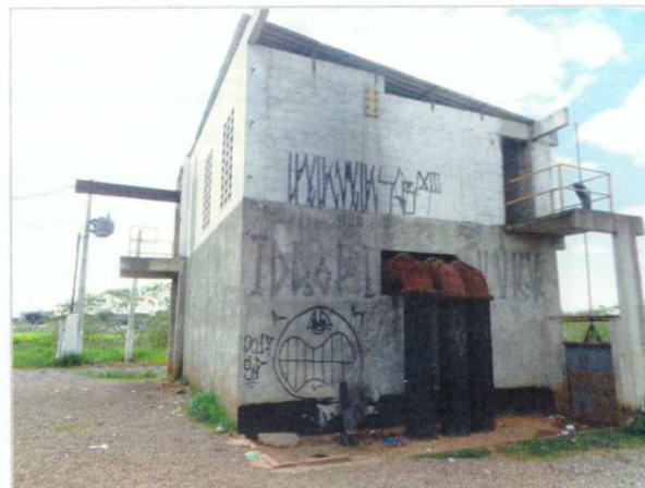
Foto 12. Estação elevatória – sistema de drenagem
