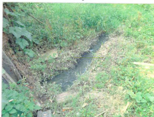
Foto 18. R. Portêncio Alves – Extravasamento de esgoto
