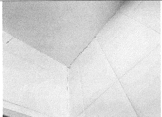
Figura 9 -Trinca no banheiro
