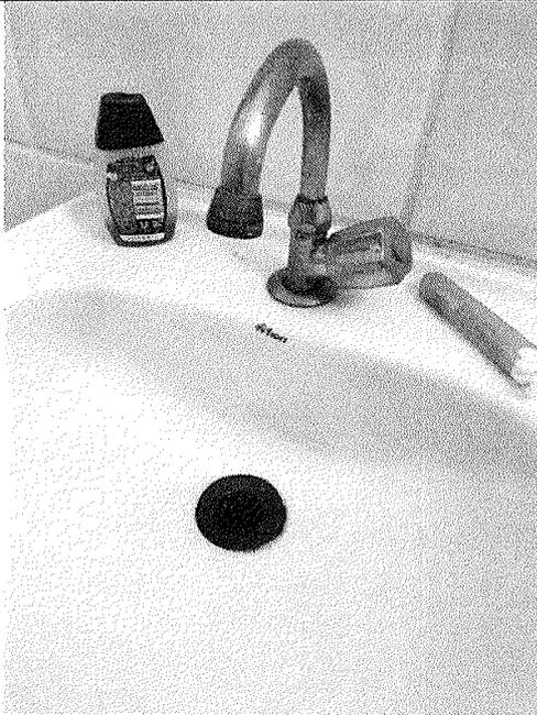
Figura 10 -Torneira com vazamento
