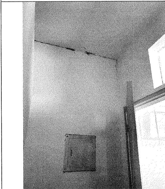
Figura 8 -Trinca no corredor
