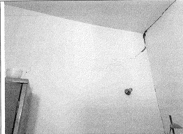
Figura 6 – Trinca na cozinha
