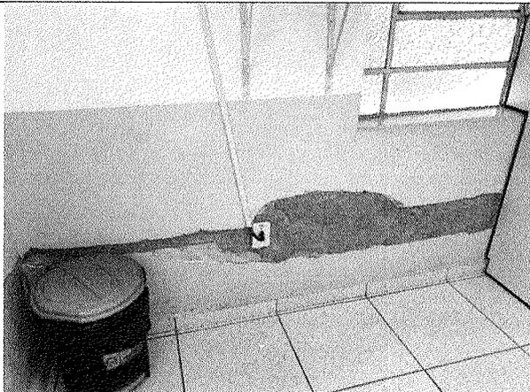
Figura 4 – Descolamento do reboco em diversas áreas
