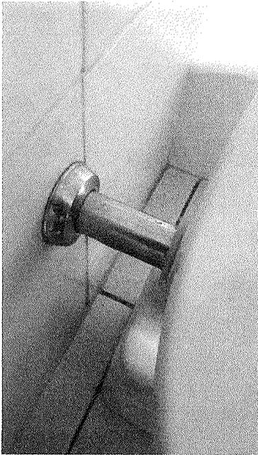
Figura 6 – Encanamento da bacia sanitária com vazamento
