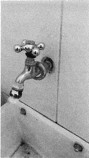
Figura 10 -Vazamento na torneira
