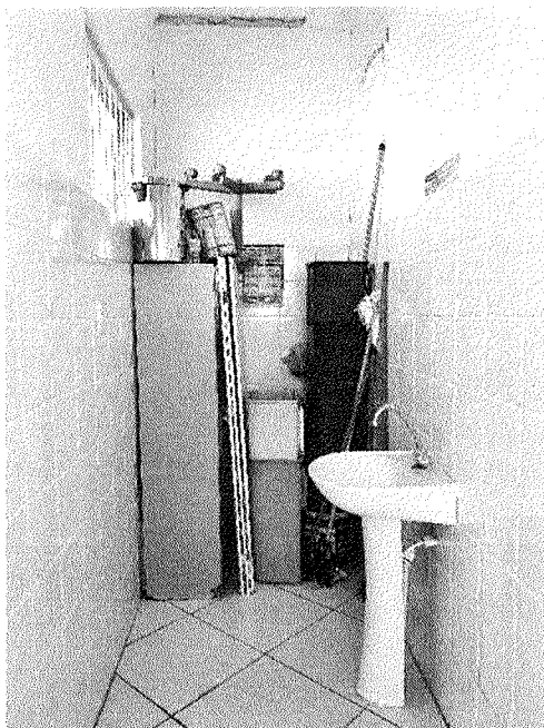
Figura 10 – Descolamento de gesso, ralo entupido e janela danificada da sala do lixo hospitalar.
