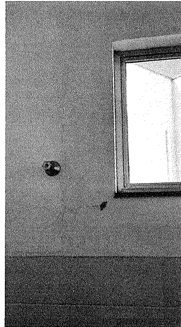
Figura 3 – Trinca de 45° na extremidade da janela do banheiro.
