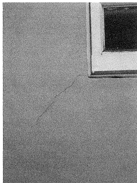
Figura 5 – Trinca na parede.
