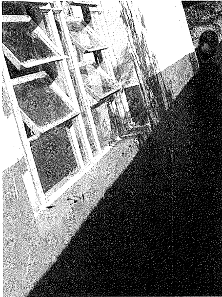
Figura 10 – Descascamento da pintura e do reboco na parte externa do UBS.
