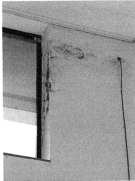
Figura 3 – Infiltração por umidade na parede da recepção.
