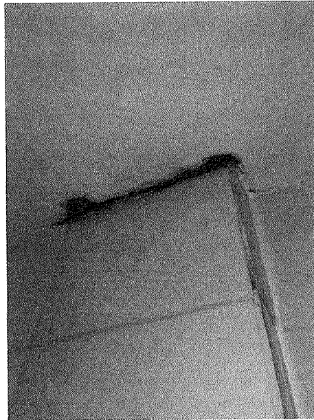
Figura 7 – Infiltração na parede da cozinha.
