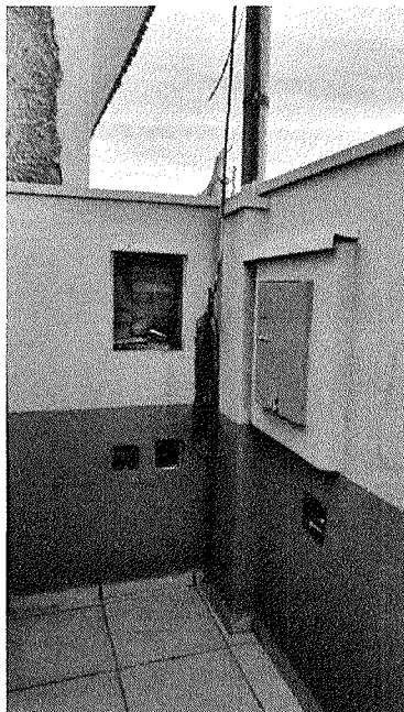
Figura 16 – Fiação exposta
