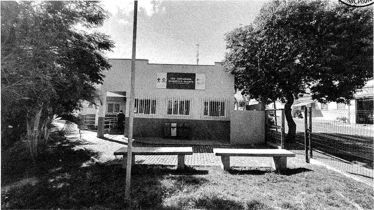
Figura 1 - Fachada da UBS Esplanada Gilberto M. Duarte
