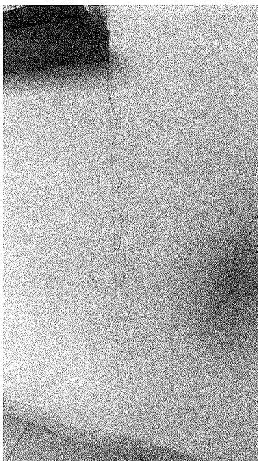
Figura 12 – Trinca
