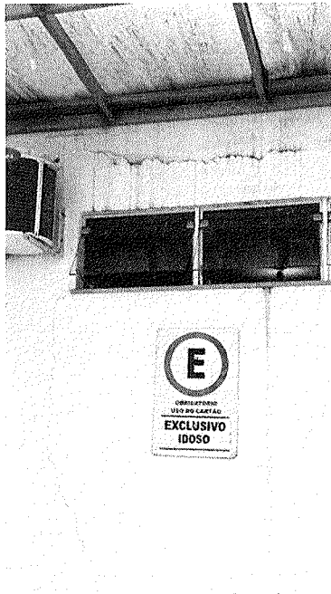
Figura 10 – Infiltração
