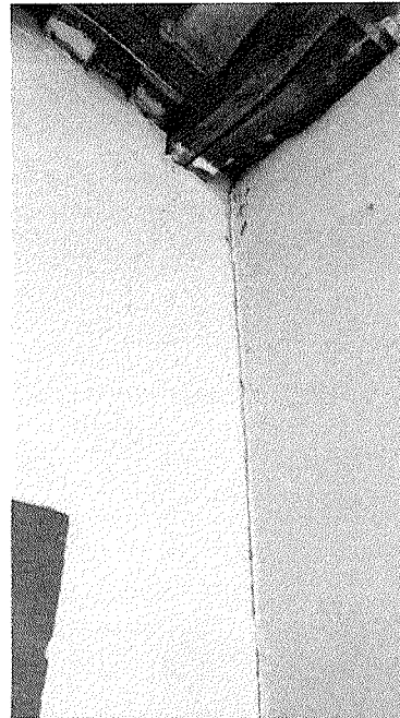
Figura 7 – Trinca
