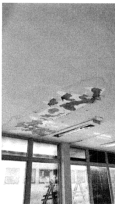
Figura 14 – Infiltração na laje
