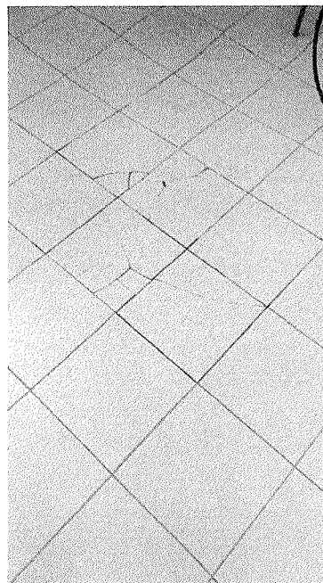
Figura 23 – Piso quebrado na recepção
