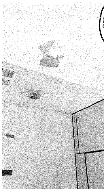
Figura 15 – Infiltração na laje
