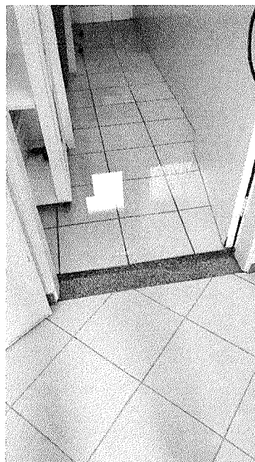
Figura 11 – Piso desnivelado
