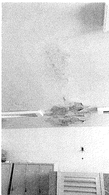
Figura 18 – Infiltração na laje
