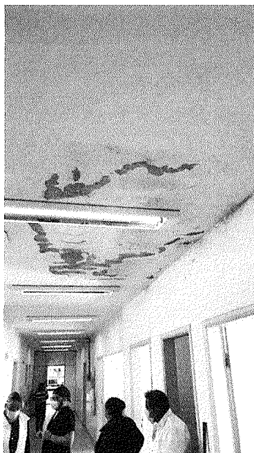
Figura 14 – Infiltração na laje
