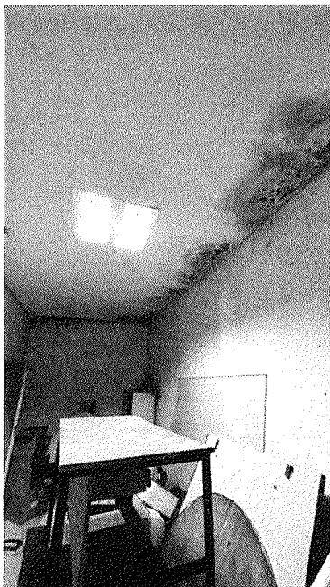
Figura 18 – Infiltração na laje
