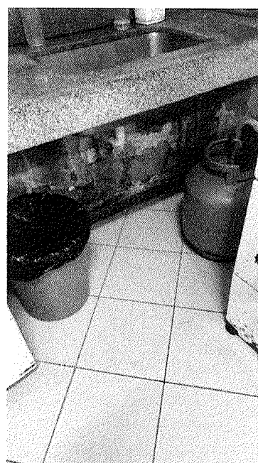
Figura 15 – Infiltração na laje
