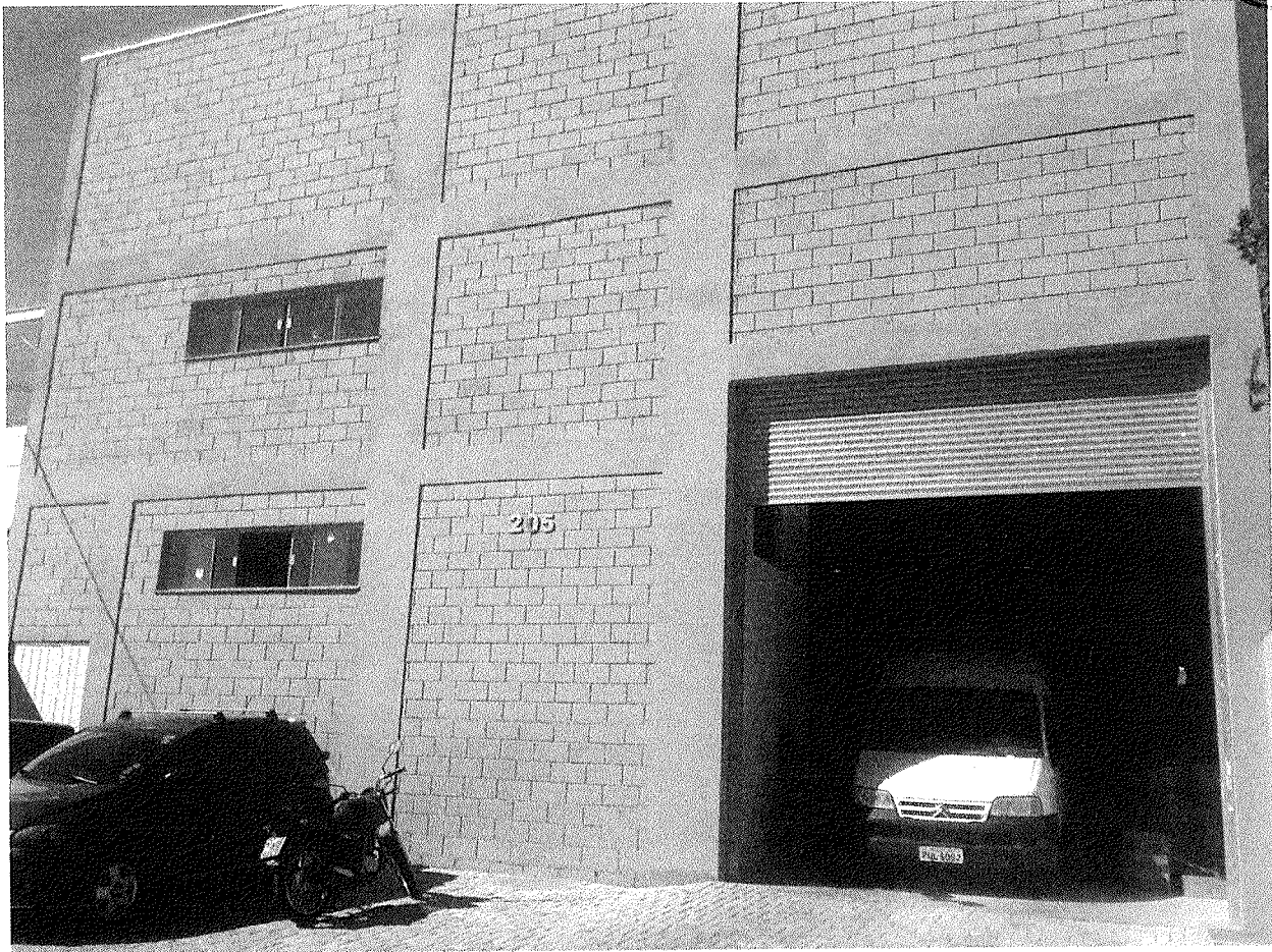
Figura 1 - Fachada do Depósito da Saúde.
