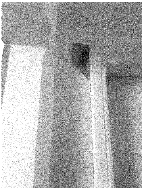
Figura 32 – Reboco danificado
