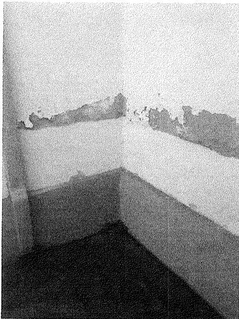
Figura 6 – Estufamento da pintura
