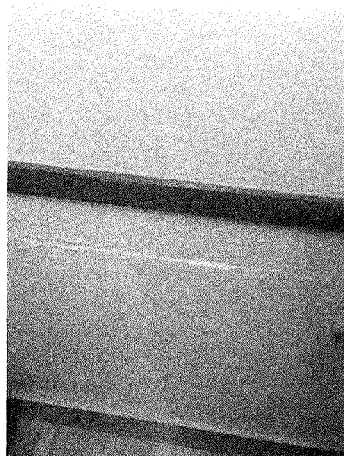
Figura 15 – Trinca na parte superior da parede
