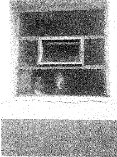
Figura 14 – Trinca
