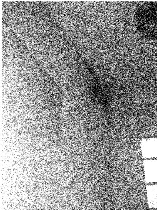
Figura 22 – Infiltração e danificação do acabamento.
