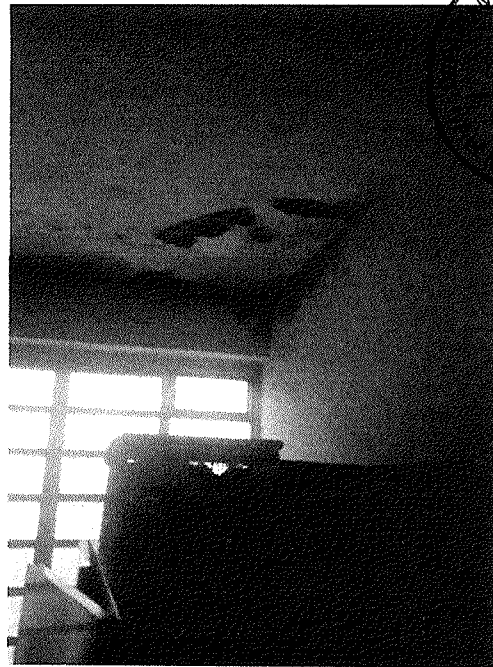
Figura 19 – Infiltração e danificação do acabamento.
