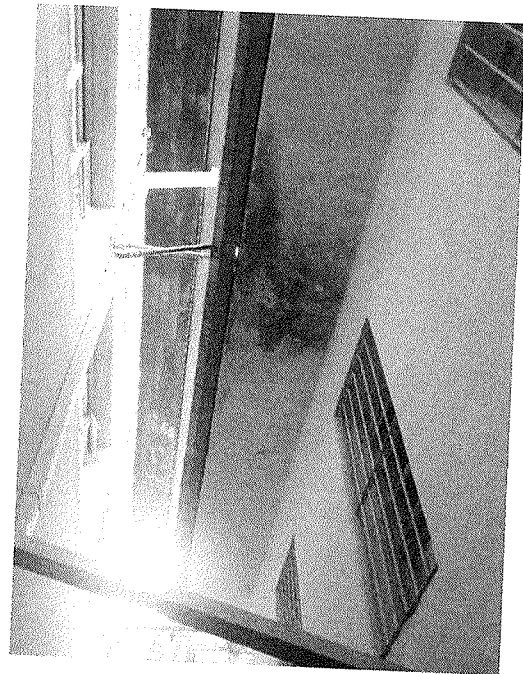
Figura 13 – Infiltração
