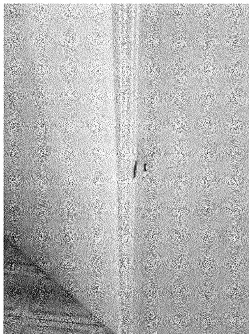
Figura 31 – Trinca entre as paredes
