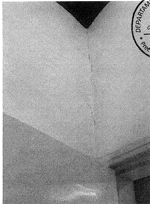
Figura 31 – Trinca entre as paredes
