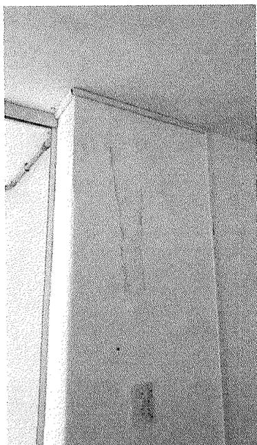
Figura 6 – Infiltração na sala odontológica.
