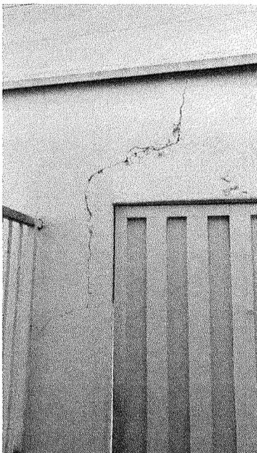
Figura 10 – Trinca na parede do portão de acesso lateral.
