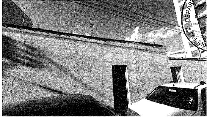
Figura 17 – Rachaduras na alvenaria de vedação.
