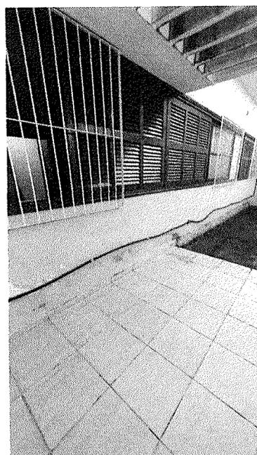
Figura 23 – Infiltração e trincas na área externa.
