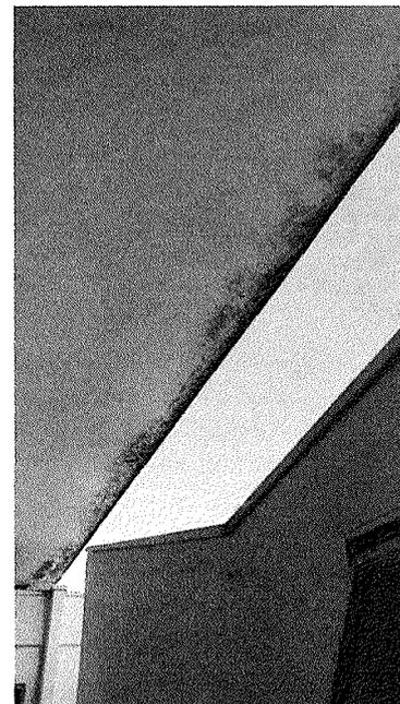
Figura 15 – Infiltração no teto por falta de calha.
