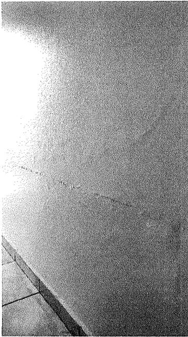
Figura 8 – Bolhas na pintura decorrentes da umidade.
