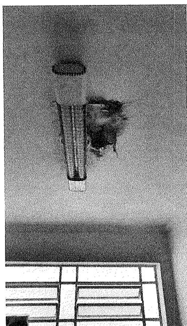
Figura 22 – Laje com rachaduras e mofo –
