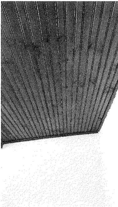
Figura 18 – Forro com infestação de cupins.
