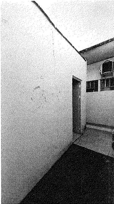
Figura 12 – Trinca da base ao teto na área externa.
