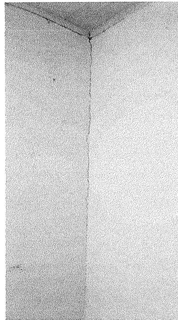
Figura 13 – Trinca.
