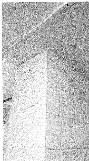
Figura 5 – Trinca na parte superior da parede.
