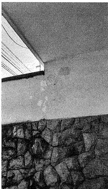
Figura 2 – Infiltração
