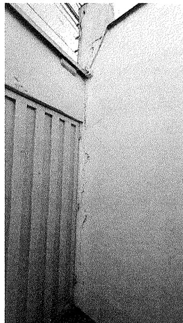
Figura 11 – Trinca na parede do portão de acesso lateral.
