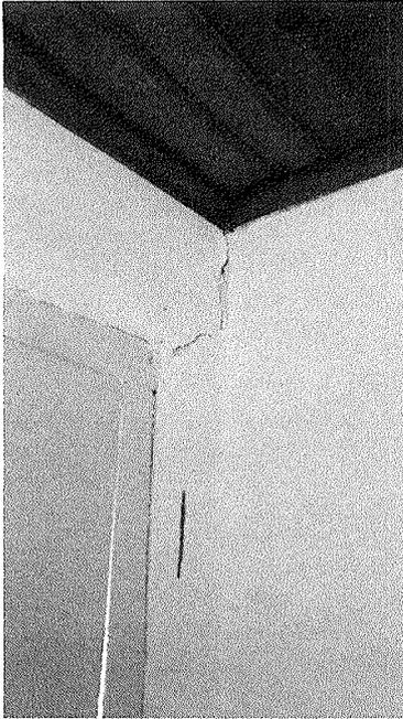
Figura 16 – Trinca no banheiro.
