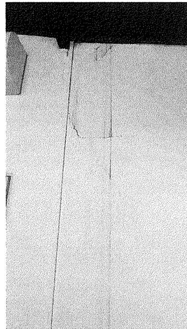
Figura 19 – Trincas e infiltração.
