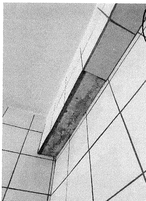
Figura 19 – Falta de revestimento.
