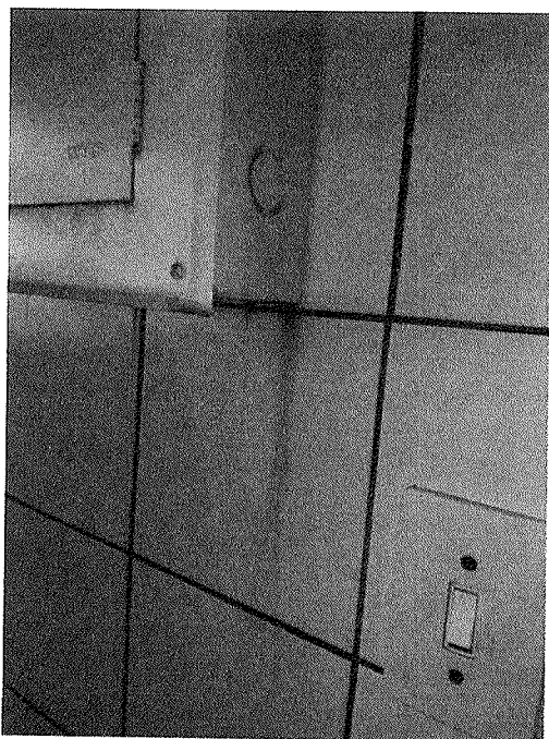
Figura 2 – Infiltração.
