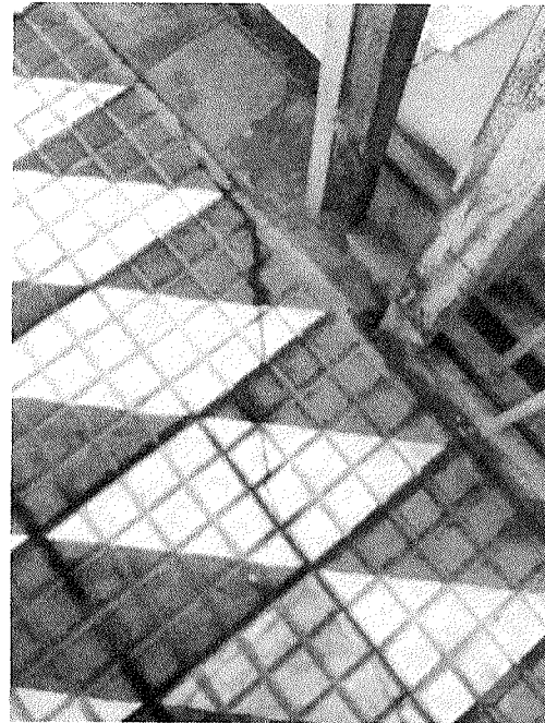
Figura 31 – Reboco danificado.
