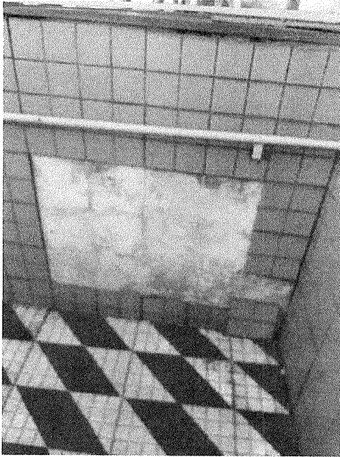
Figura 30 – Revestimento solto.
