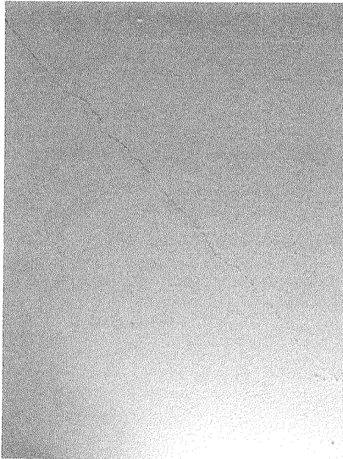
Figura 14 – Trinca na laje.
