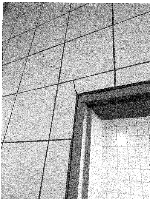
Figura 6 – Infiltração.
