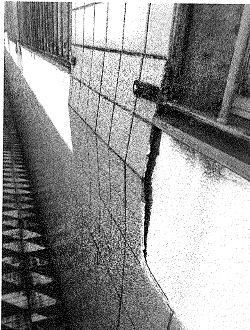
Figura 28 – Revestimento danificado.
