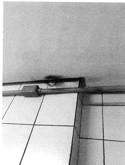
Figura 15 – Infiltração.
