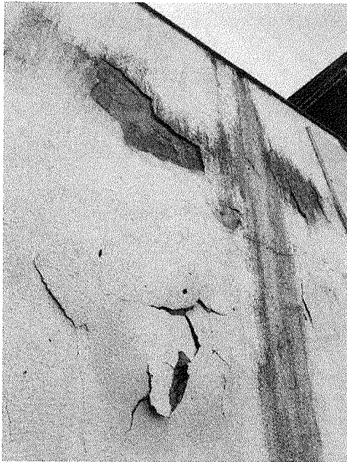
Figura 30 – Revestimento solto.
