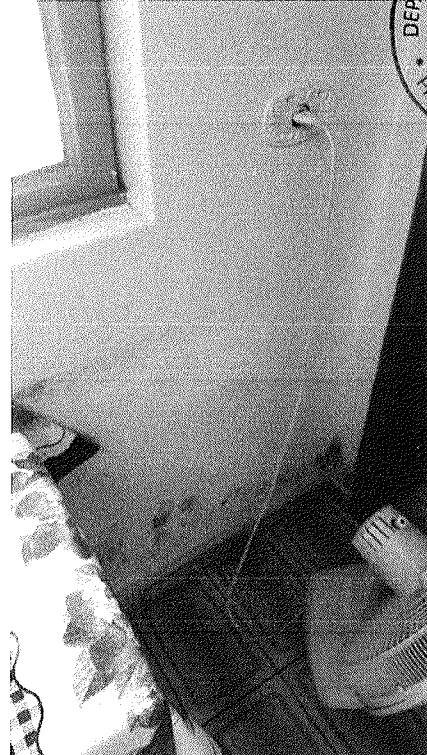
Figura 31 - Umidade e trinca na cozinha
