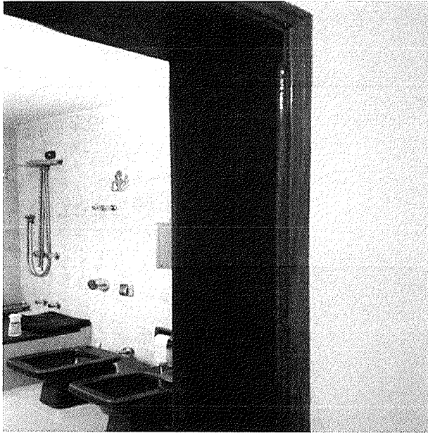
Figura 34 - Portal em mau estado de conservação
