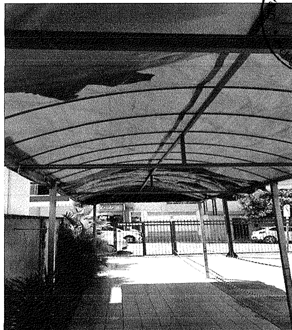
Figura 3 - Cobertura em mau estado de conservação, área externa
