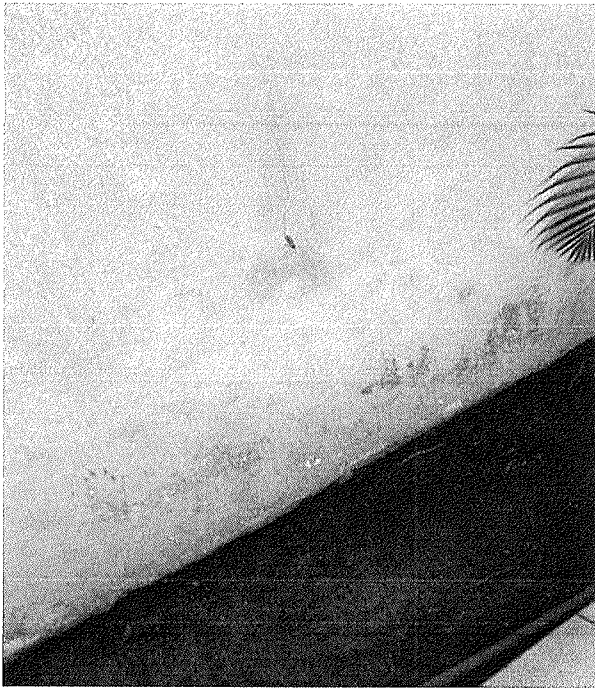
Figura 14 - Pintura danificada, área externa
