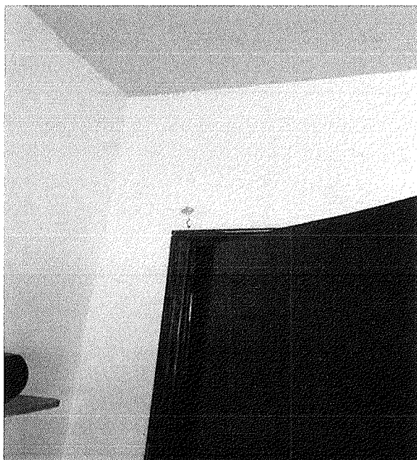
Figura 10 - Fiação exposta, sala 3
