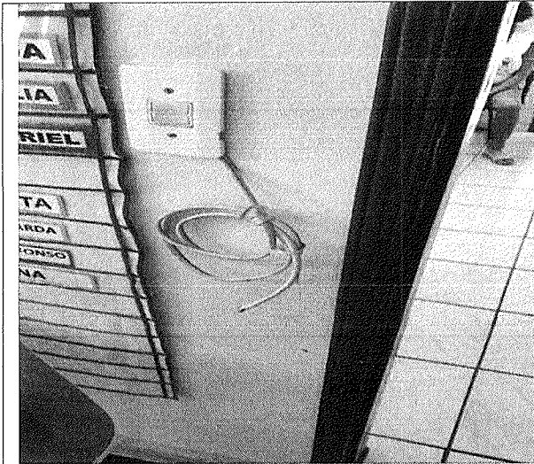
Figura 6 - Fiação exposta, sala 3
