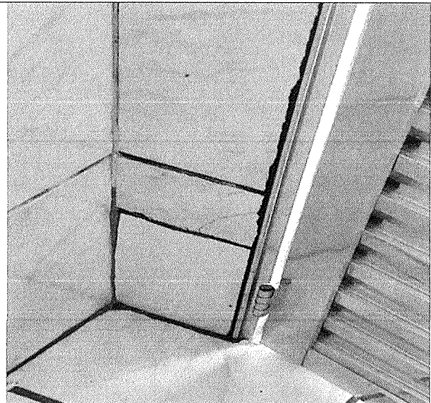
Figura 23 - Trinca na parede, sala 3
