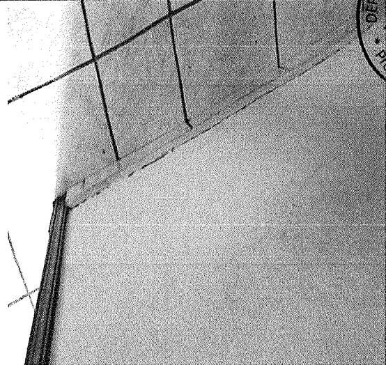
Figura 19 - Trinca corredor
