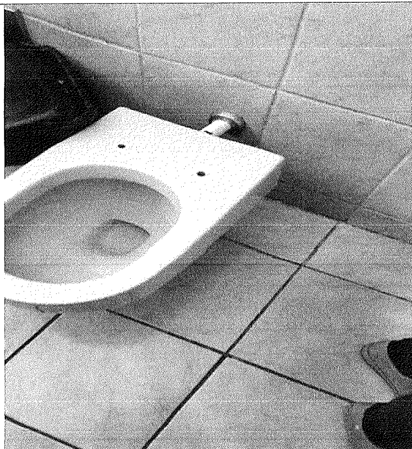
Figura 2 - Ausência de tampa, banheiro
