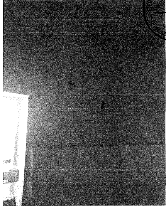
Figura 11 - Fiação exposta, banheiro do refeitório
