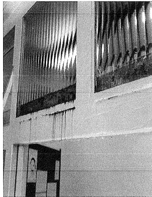
Figura 7 - Descolamento do reboco, área externa
