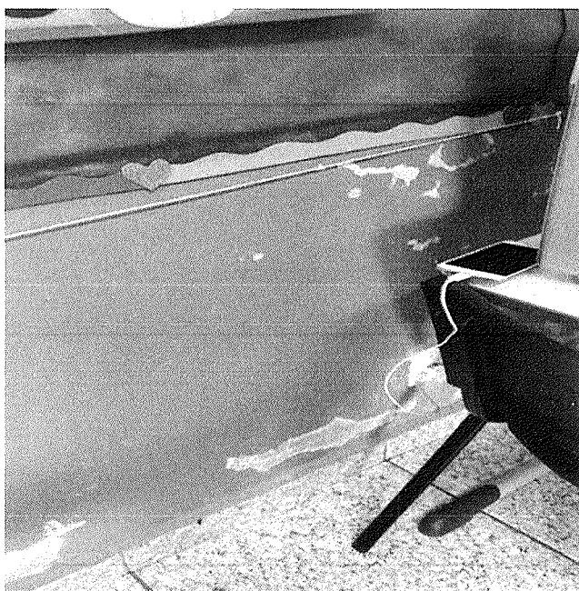
Figura 14 - Infiltração, banheiro do refeitório
