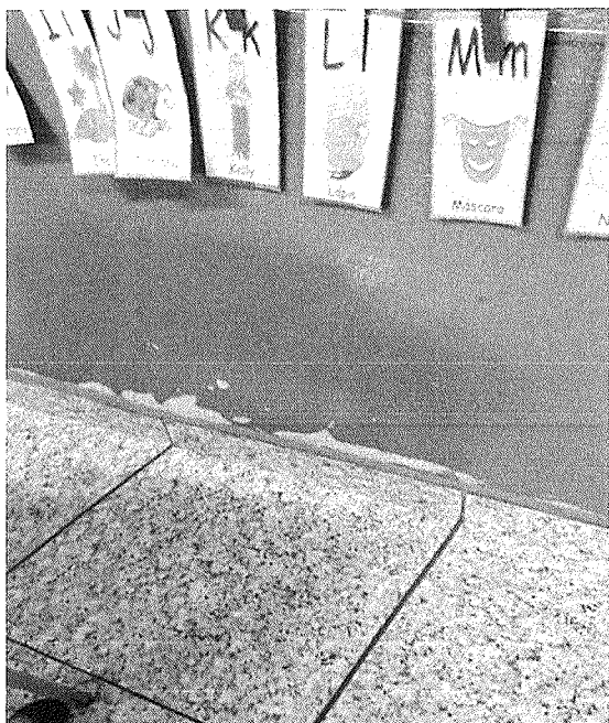
Figura 38 - Umidade, sala 2
