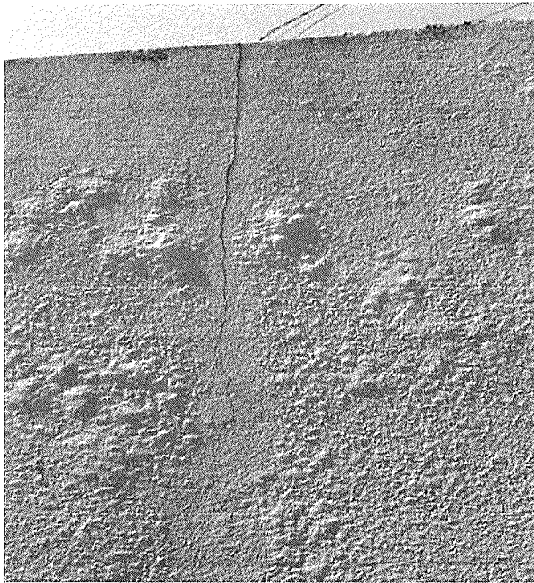
Figura 30 - Trinca e deslocamento do reboco, área externa
