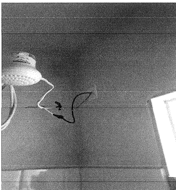
Figura 15 - Infiltração, lavanderia
