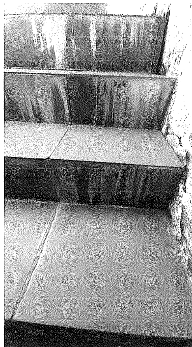
Figura 19 – Revestimento danificado.
