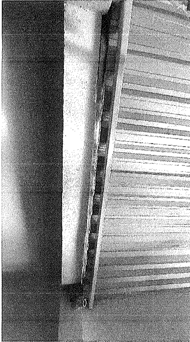
Figura 10 – Calha danificada.
