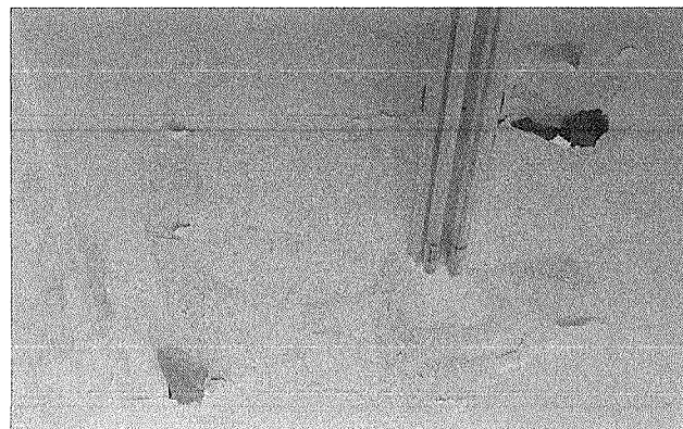
Figura 19 – Revestimento danificado.
