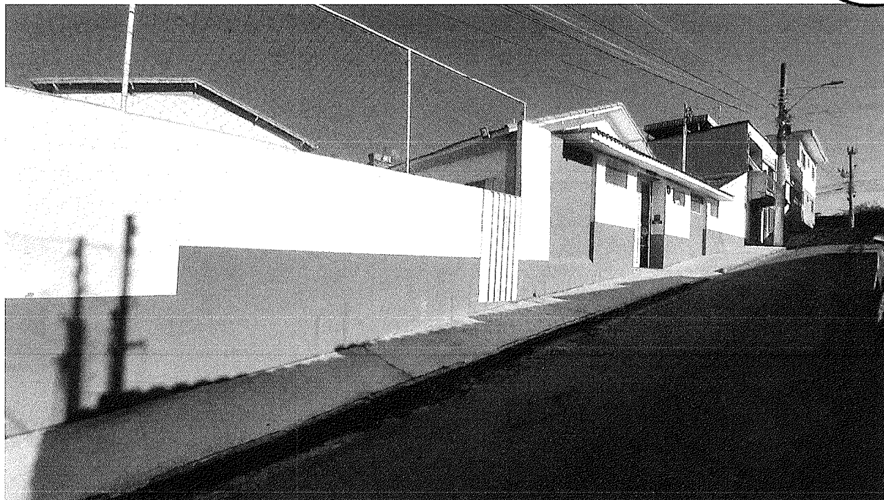
Figura 1 - Fachada do CMEJA
