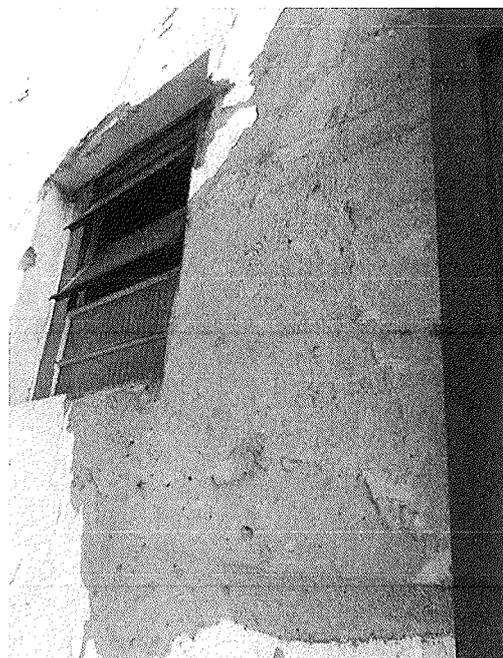
Figura 21 - Descascamento da pintura
