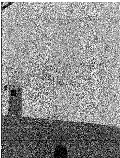
Figura 20 - A parte externa do local apresenta trincas e estufamento da pintura
