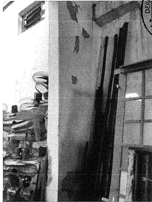
Figura 3 - Descascamento da pintura
