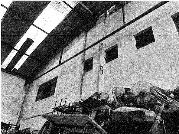
Figura 4 - Infiltrações, trincas e estufamento da pintura por todo local
