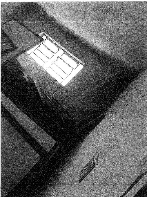
Figura 18 - Infiltração e estufamento da pintura
