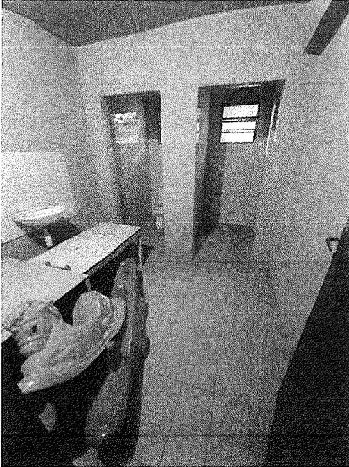
Figura 10 - Sanitários e pia sem funcionamento
