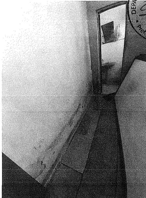
Figura 19 - Descascamento da pintura por umidade e infiltração
