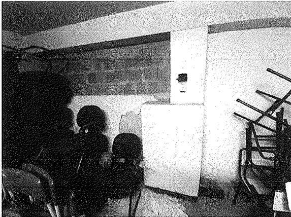
Figura 8 - Umidade, trinca e falta de reboco na parede
