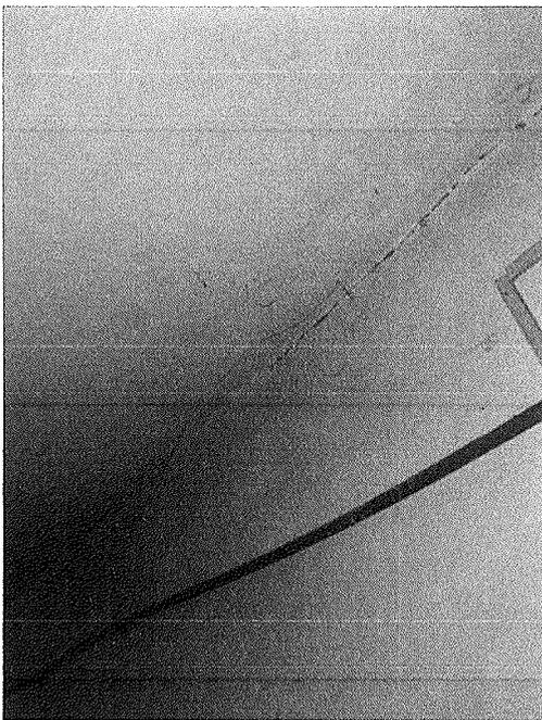
Figura 16 - Trinca entre parede e laje
