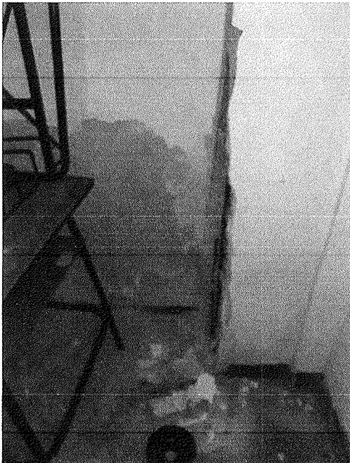
Figura 12 - Descolamento da pintura por umidade e pilar com ferrugem aparente
