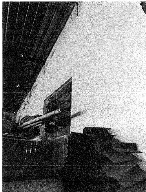
Figura 17 - Parede com estufamento na pintura e algumas trincas
