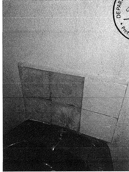
Figura 3 - Revestimento danificado
