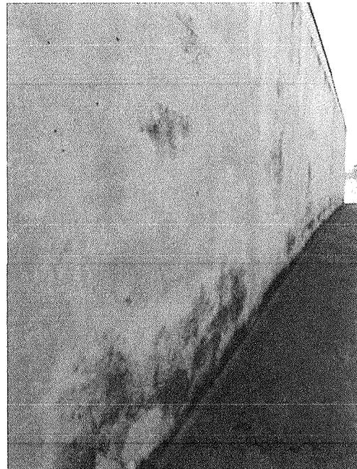
Figura 17 - Infiltração e descascamento da pintura com algumas trincas aparentes na parte exterior da edificação
