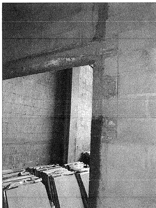
Figura 9 - Falta de acabamento na parede
