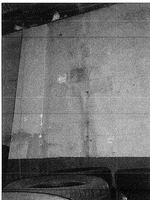
Figura 8 - Infiltração na parede
