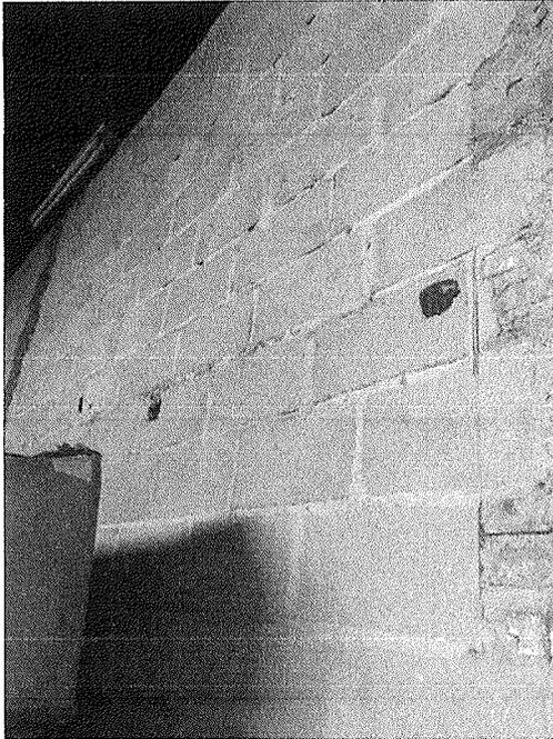
Figura 14 - Parede com buracos e sem reboco
