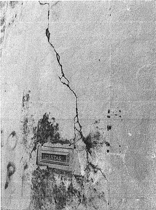
Figura 2 - Trinca estrutural na parte de fora do edifício
