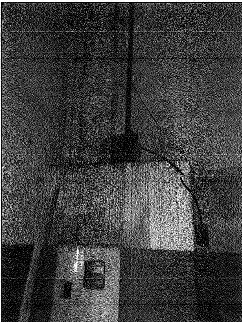
Figura 16 - Fiação exposta no quadro geral
