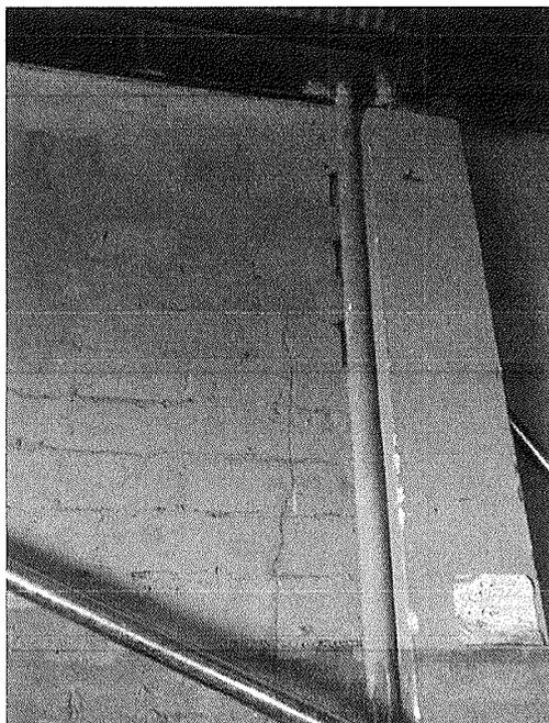
Figura 12 - Trinca na parede
