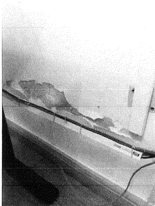
Figura 22 - Trinca que apresenta goteiras na sala do RH
