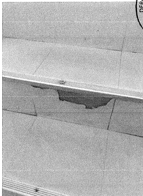
Figura 27 - Piso quebrado no espelho da escada que dá acesso à cozinha
