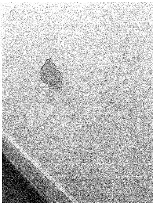
Figura 10 - Trincas, tinta descascadas e bolhas na pintura no departamento financeiro
