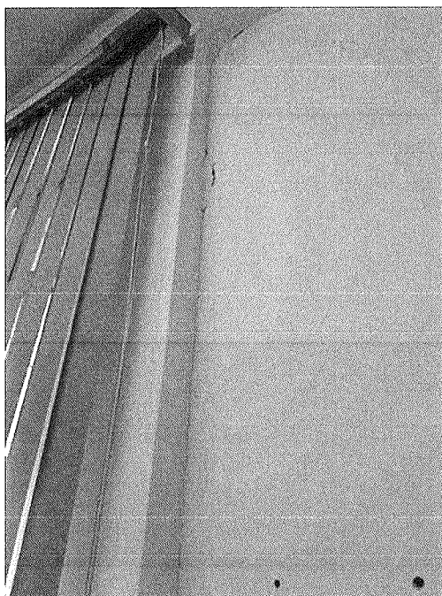
Figura 26 - Trinca na junção pilar e parede na sala do pedagógico
