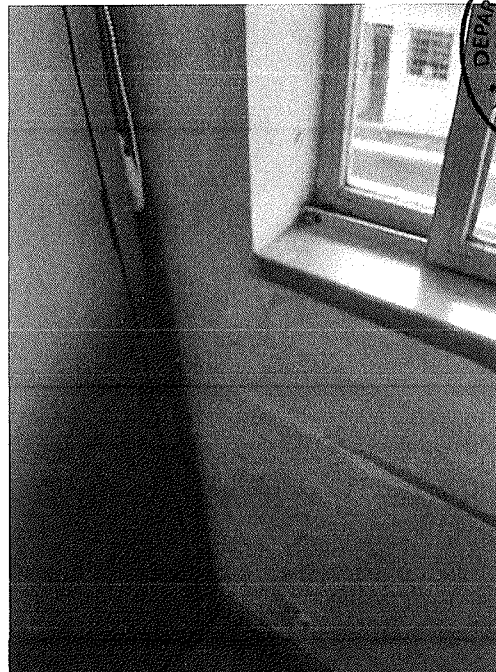
Figura 7 - Trincas e tinta descascando por umidade na janela da sala do departamento administrativo
