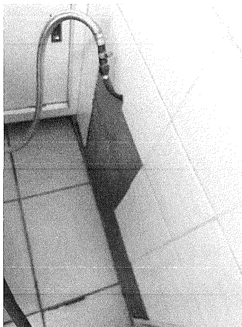
Figura 27 - Piso quebrado no espelho da escada que dá acesso à cozinha
