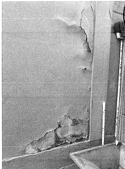
Figura 31 - Infiltração com estufamento da pintura no muro
