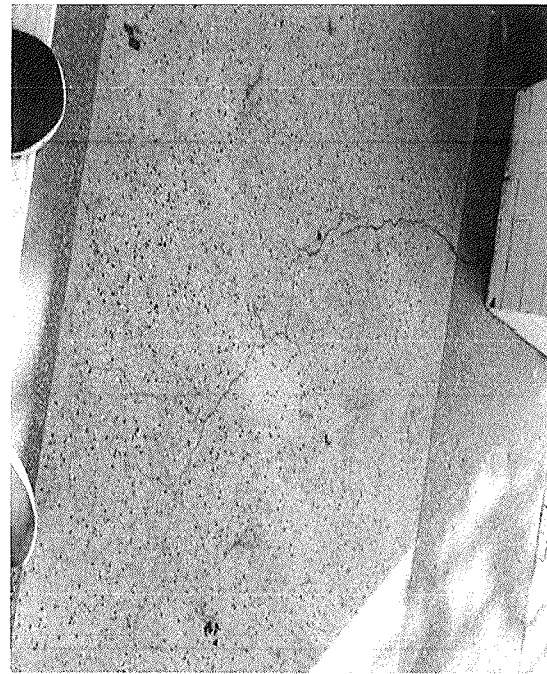
Figura 11 - Trinca na laje, cômodo 3
