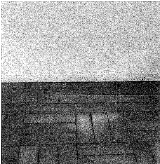
Figura 18 - Rodapé danificado, cômodo 8
