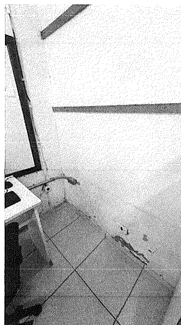
Figura 11 - Revestimento danificado, sala de aula 8
