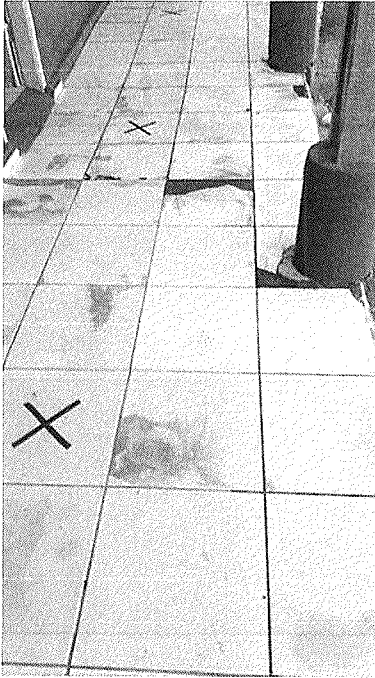
Figura 6 - revestimento danificado e umidade, corredor próximo à sala 2
