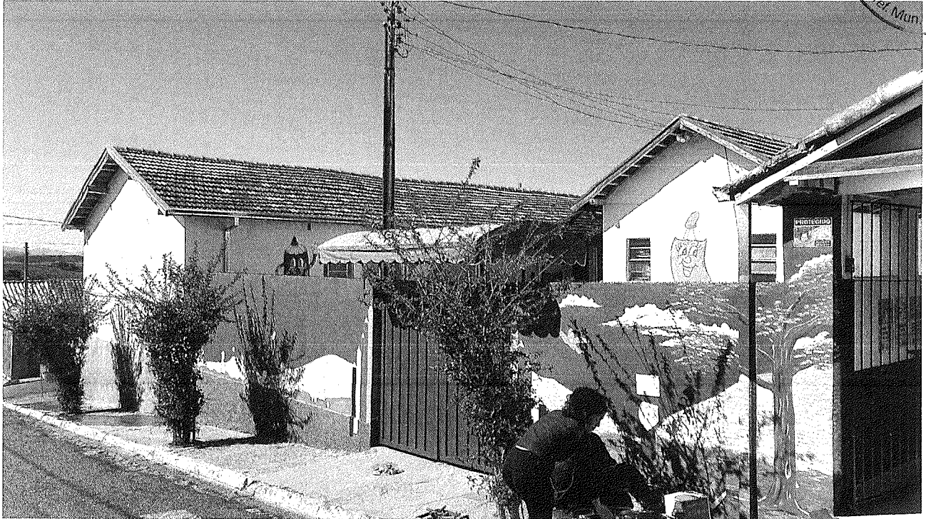
Figura 1 – Fachada: Comunidade Alegrinho
