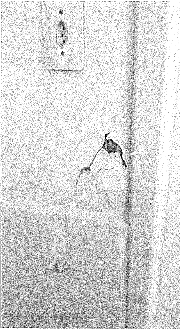
Figura 18 - Danos ao revestimento da parede. Banheiro masculino, área externa
