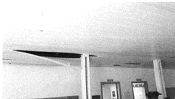
Figura 17 - Forro danificado
