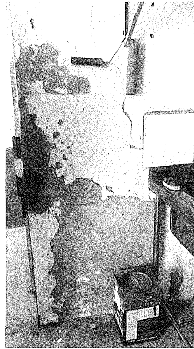
Figura 23 - Revestimento danificado, lavanderia
