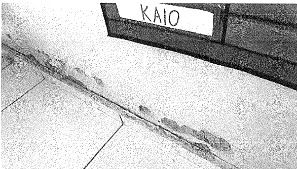
Figura 6 - revestimento danificado e umidade, corredor próximo à sala 2
