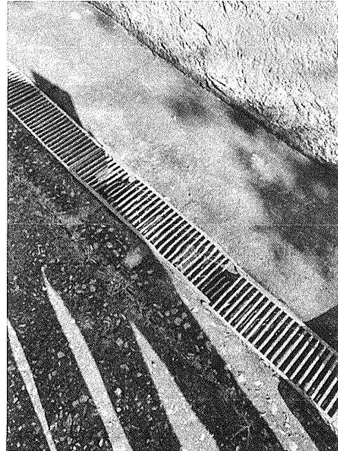
Figura 39 - Grelhas quebradas
