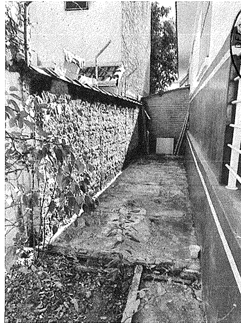
Figura 51 - Lateral da edificação
