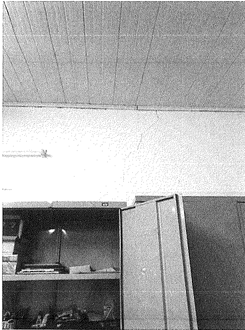
Figura 26 - Trincas na sala 4
