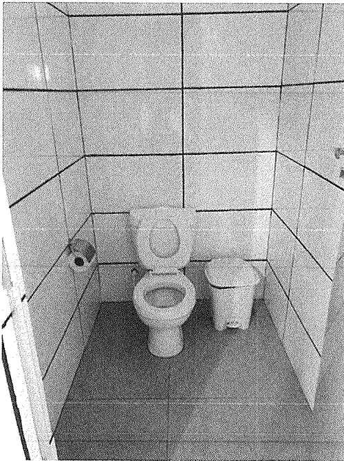
Figura 46 - Banheiro acessível sem as barras
