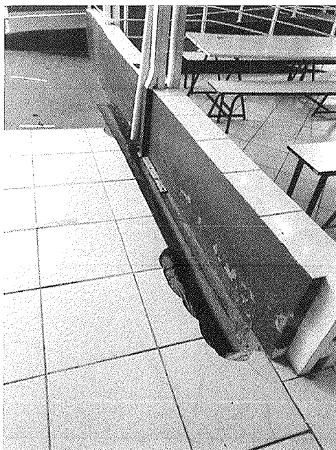
Figura 30 - Caixa de grelha sem tampa
