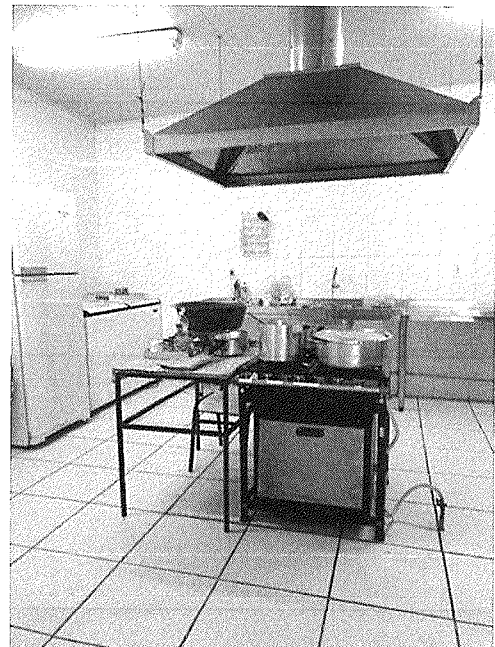
Figura 21 - Na cozinha não foram encontradas patologias
