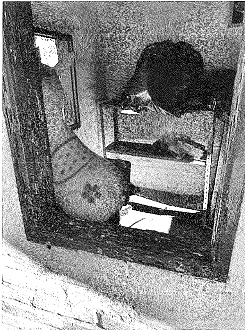
Figura 38 - Estruturas em madeira danificadas
