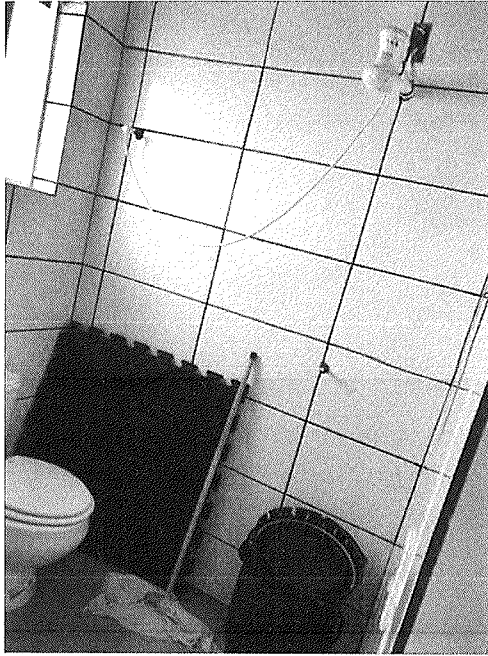
Figura 46 - Banheiro acessível sem as barras
