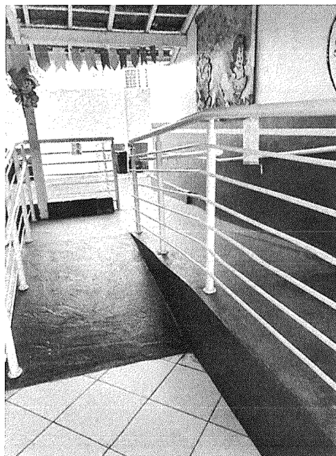
Figura 43 - Guarda corpo 3 corrimão na rampa interna
