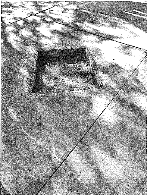
Figura 34 - Ralo com tampa solta na área de serviço
