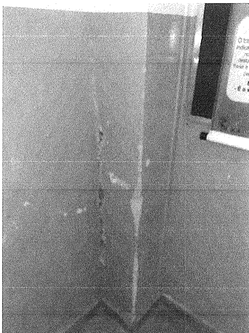
Figura 78 - Reboco danificado
