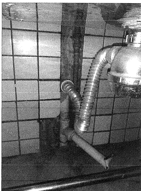
Figura 23 - Pia com instalação inapropriada
