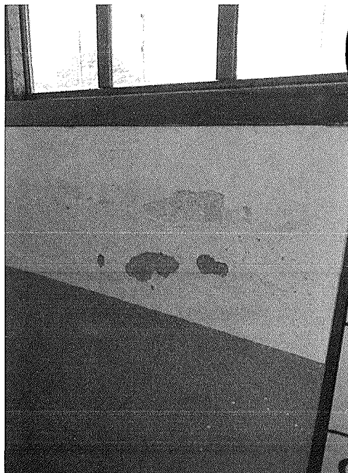
Figura 95 - Infiltração na parede
