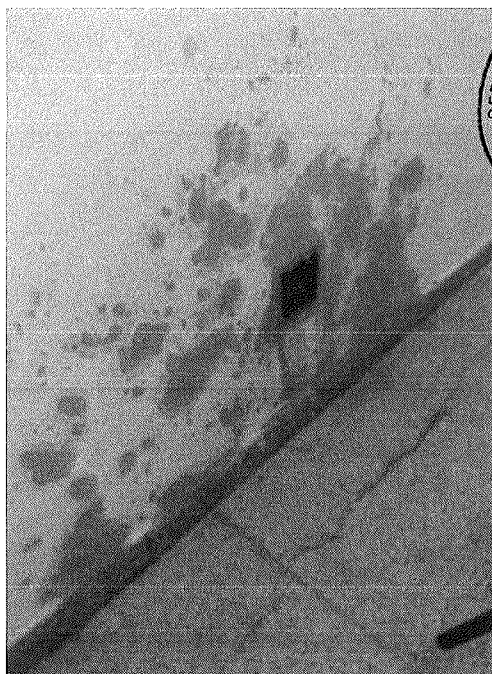
Figura 83 - Infiltração na parede
