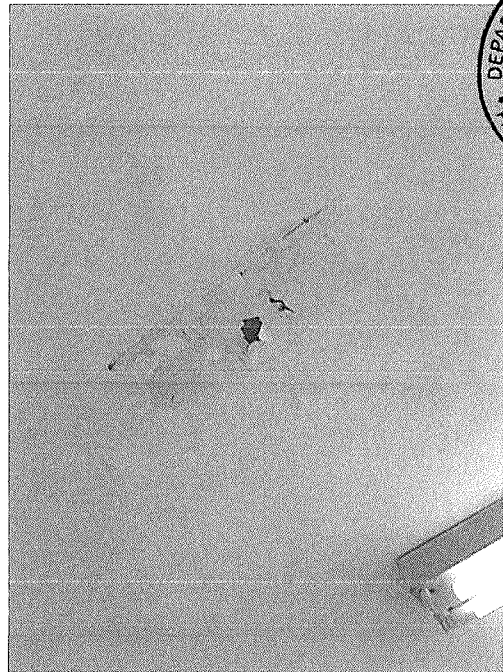
Figura 43 - Descascamento da pintura e infiltração na laje
