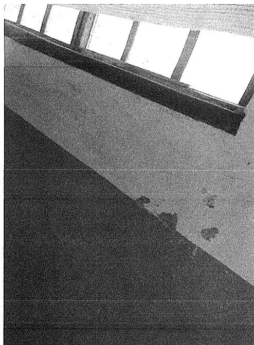
Figura 91 - Infiltração e reboco danificado
