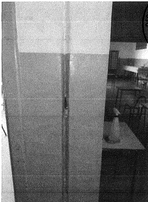
Figura 39 - Trinca na parede
