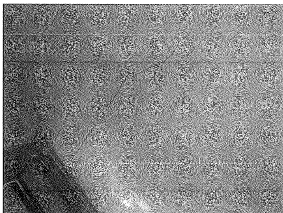
Figura 6 - Trinca na parte superior da parede
