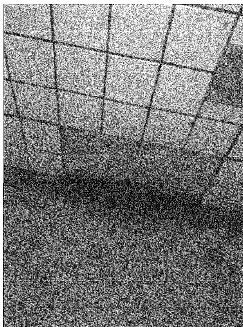
Figura 109 - Revestimento danificado
