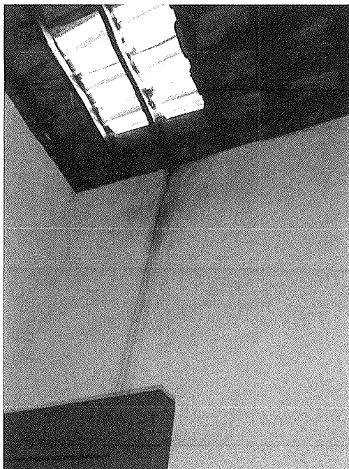
Figura 34 - Infiltração na parede
