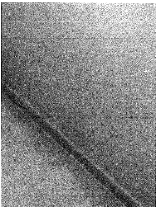
Figura 62 - Infiltração e trinca na parede
