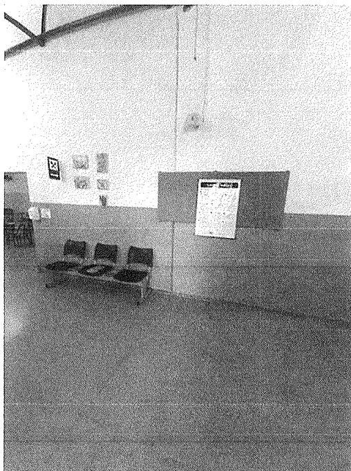
Figura 102 - Rachadura na parede
