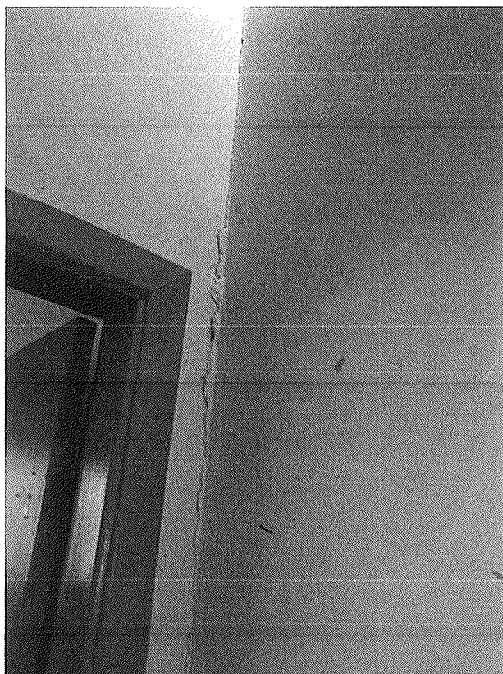
Figura 106 - Trinca entre as paredes
