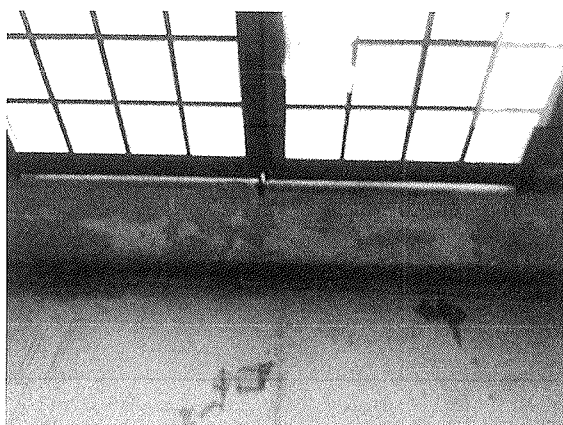
Figura 70 - Infiltração e trinca na parede
