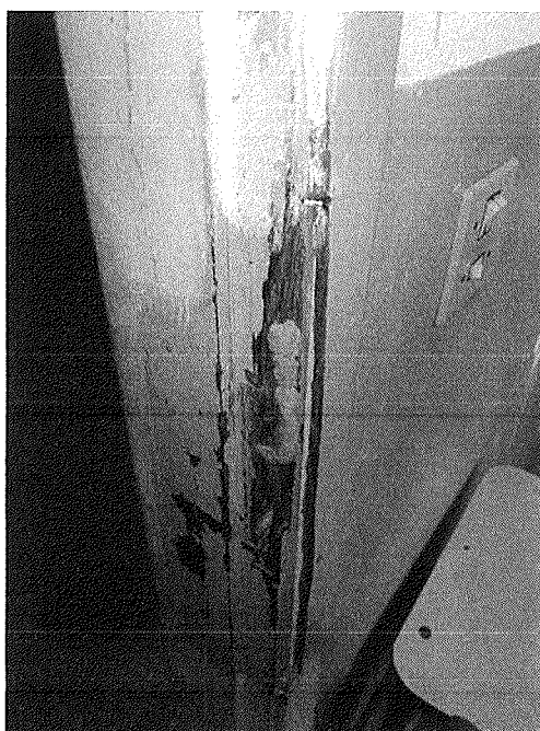
Figura 95 - Infiltração na parede
