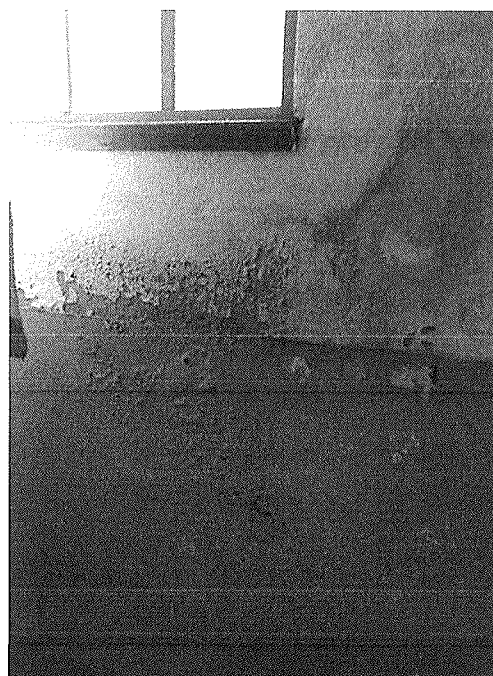
Figura 115 - Infiltração na parede
