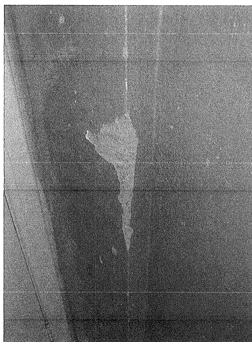
Figura 13 - Reboco danificado
