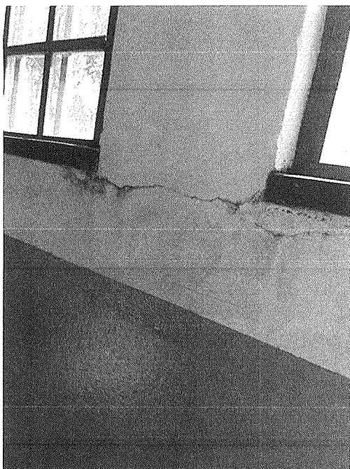
Figura 62 - Infiltração e trinca na parede
