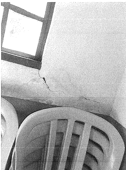
Figura 66 - Trinca na parede
