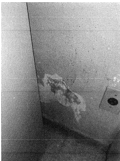
Figura 63 - Reboco danificado
