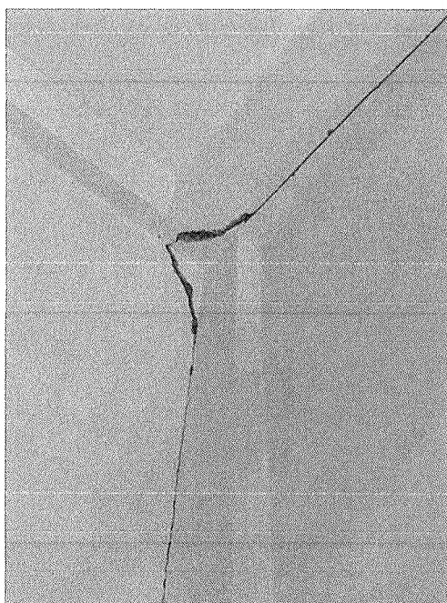
Figura 119 - Infiltração com descolamento do reboco e parte elétrica danificada
