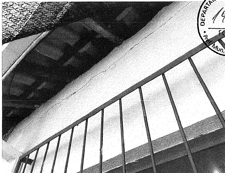
Figura 3 – Trincas.
