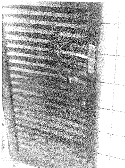
Figura 11 – Revestimento danificado.
