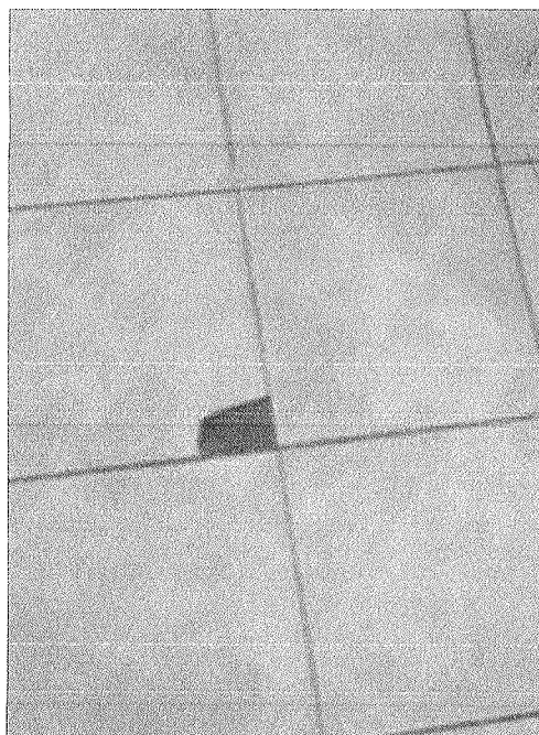
Figura 11 – Revestimento danificado.
