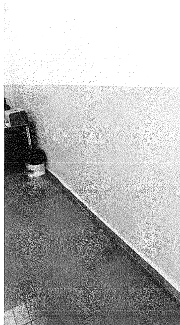
Figura 35 – Umidade na sala de orientação educacional.
