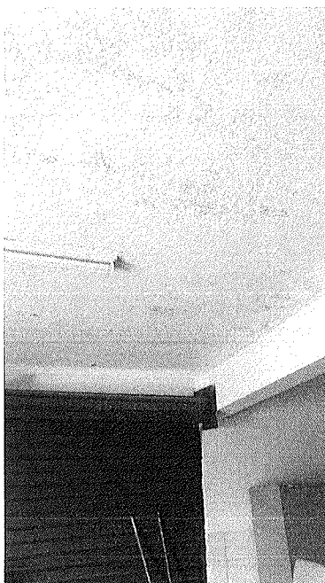
Figura 50 – Infiltração na laje da cantina.
