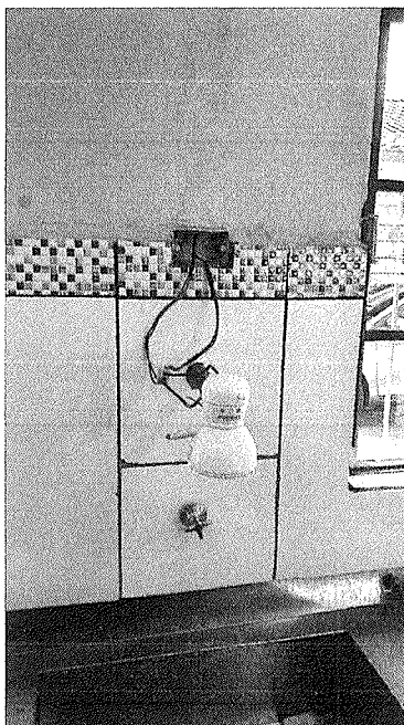
Figura 18 – Instalação elétrica precária.
