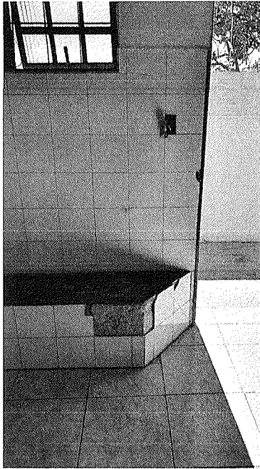
Figura 46 – Falta de revestimento cerâmico e instalação elétrica danificada.
