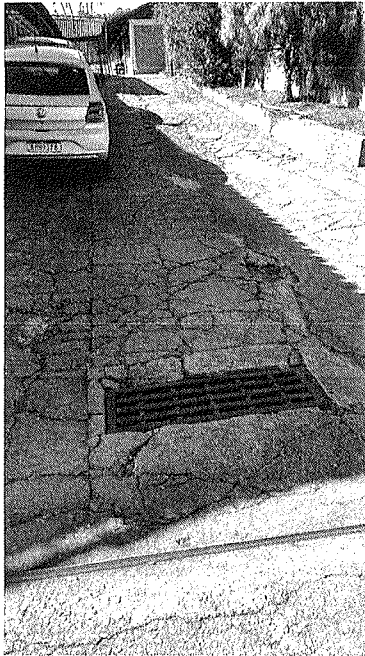
Figura 2 – Piso da entrada quebrado e desnivelado.
