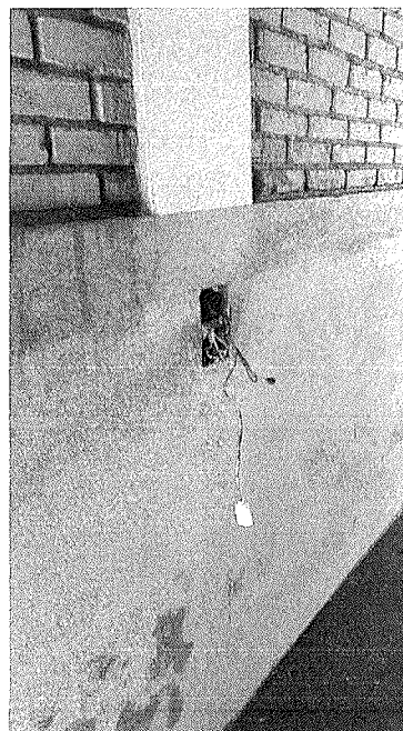
Figura 39 – Fiação exposta.
