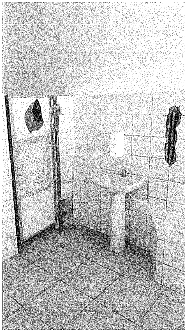
Figura 46 – Falta de revestimento cerâmico e instalação elétrica danificada.
