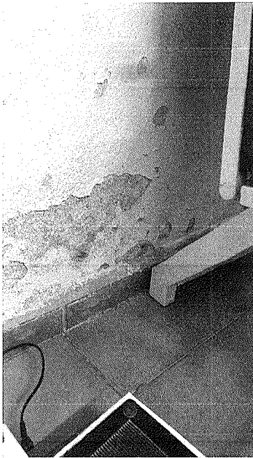
Figura 6 – Umidade.
