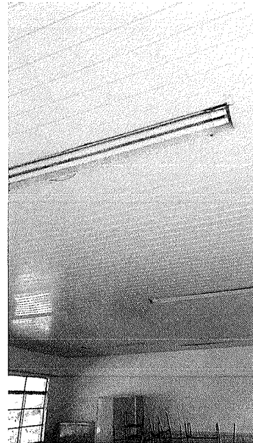
Figura 27 – Danos na luminária na sala 09.
