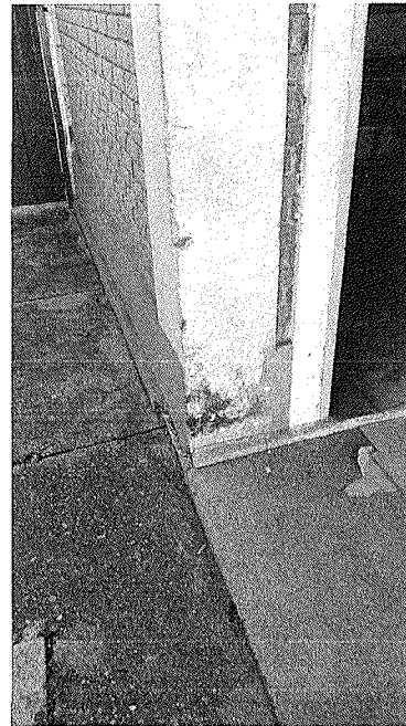
Figura 3 – Umidade.
