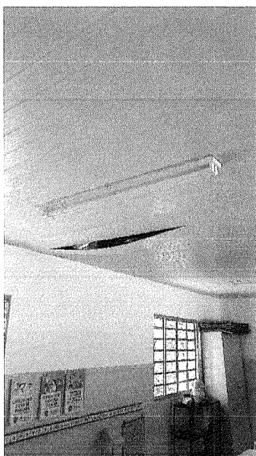
Figura 50 – Infiltração na laje da cantina.
