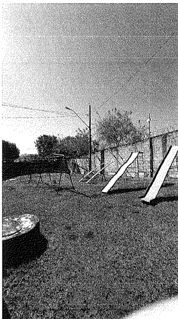
Figura 54 – Parque infantil precisando de manutenções em geral, como solda, reparo nas estruturas de madeira e nivelamento.
