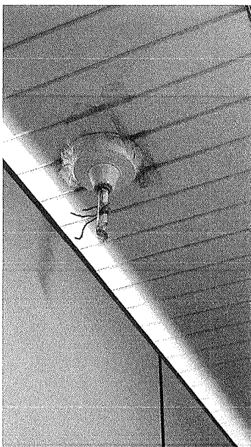
Figura 18 – Instalação elétrica precária.
