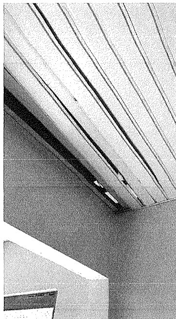
Figura 19 – Forro de PVC danificado.
