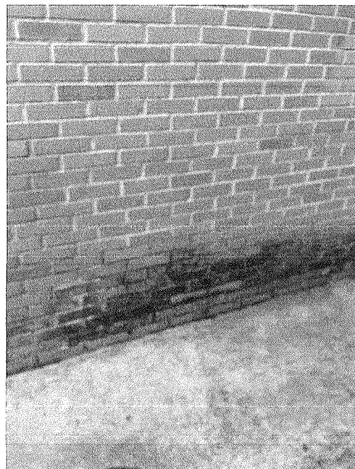
Figura 27 – Infiltração.
