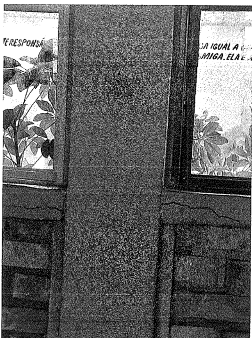
Figura 22 – Trincas.
