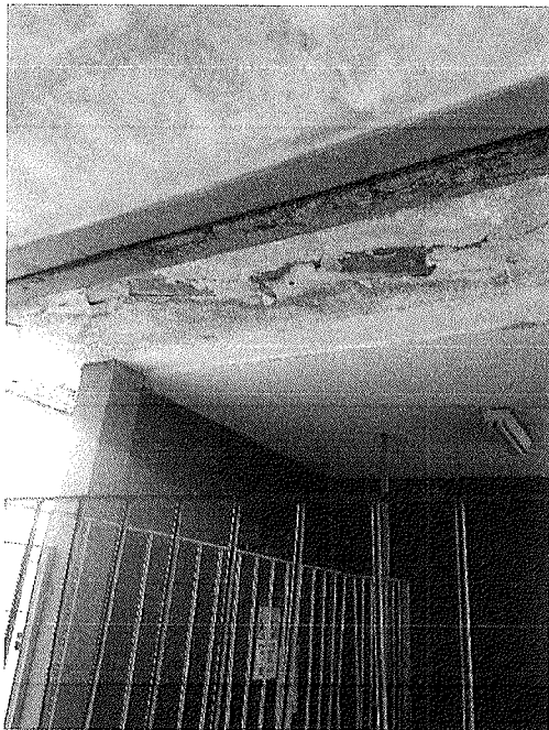
Figura 2 – Infiltração.
