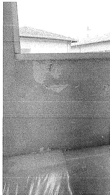
Figura 5 – Trincas no peitoril na sala 25.
