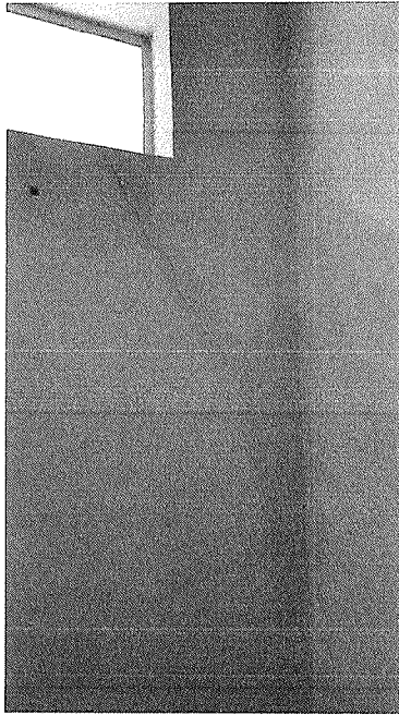
Figura 8 – Trincas nas extremidades das janelas.
