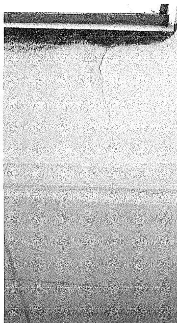
Figura 35 – Trinca no peitoril.
