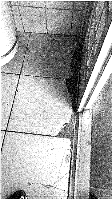
Figura 54 – Trinca extensa no refeitório.
