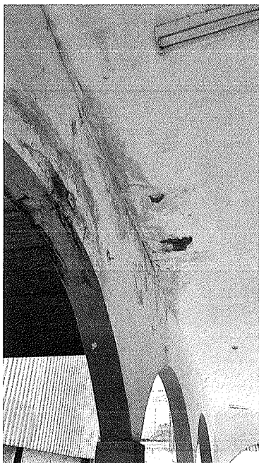
Figura 62 – Infiltração no corredor de acesso a quadra.
