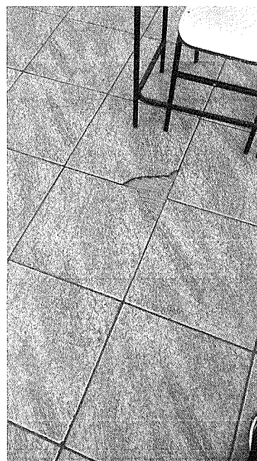
Figura 103 – Infiltração e buraco na laje da sala 45.
