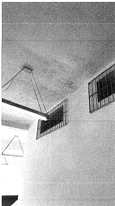
Figura 66 – Infiltração na laje do corredor.
