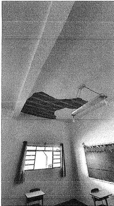
Figura 90 – Revestimento da laje danificado na sala 37.
