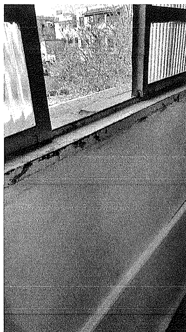
Figura 71 – Trinca na parte superior da parede na sala 25.
