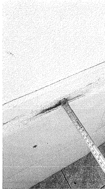
Figura 39 – Revestimento danificado na sala 16.
