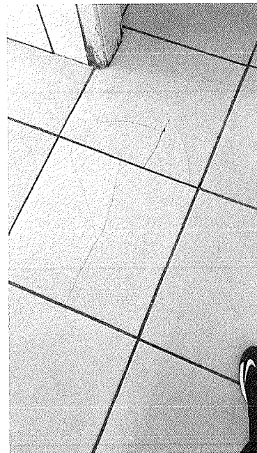
Figura 3 – Trincas no revestimento do banheiro.
