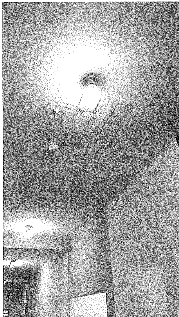
Figura 14 – Infiltração na laje.
