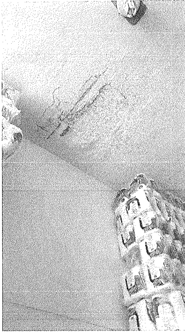
Figura 14 – Infiltração na laje.
