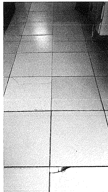
Figura 27 – Rachaduras no banheiro masculino.
