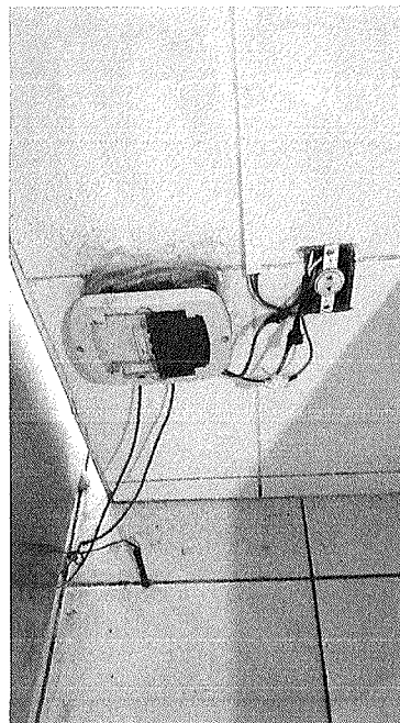
Figura 59 – Fiação exposta.
