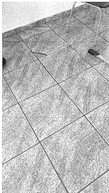
Figura 95 – Trincas na sala 39.
