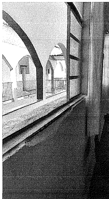
Figura 87 – Danos na janela e peitoril da sala 35.
