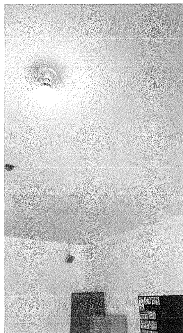
Figura 103 – Infiltração e buraco na laje da sala 45.
