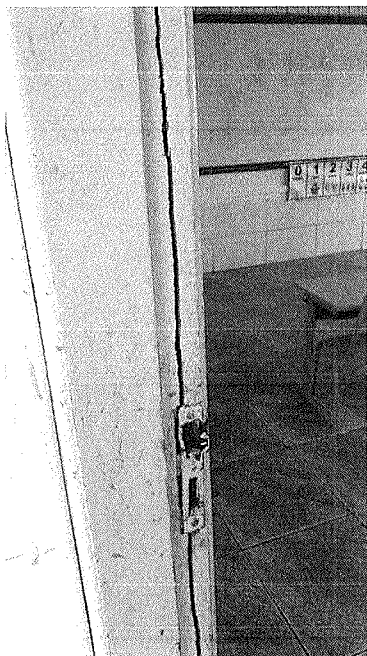
Figura 34 – Batente danificado.
