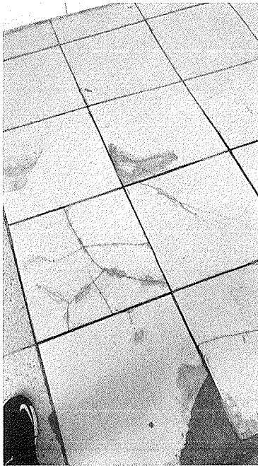
Figura 46 – Revestimento danificado no bloco infantil.
