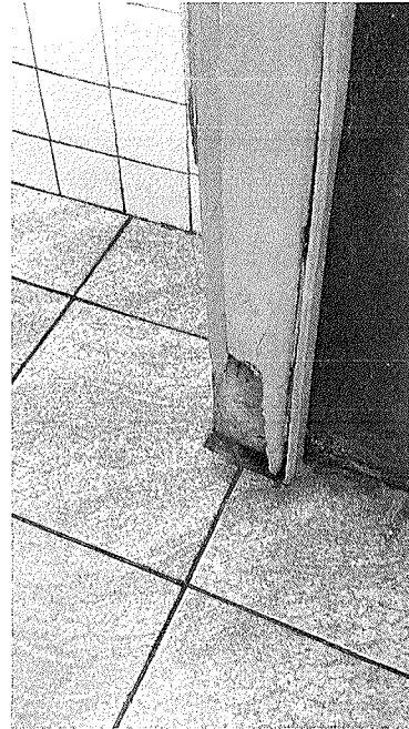
Figura 79 – Batentes danificados no banheiro masculino superior.
