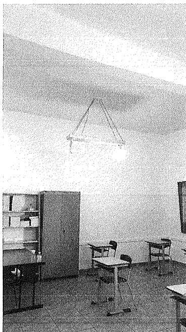
Figura 70 – Iluminação insuficiente na sala 27.
