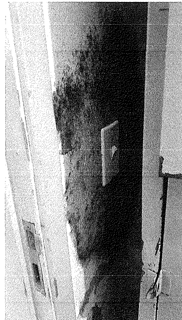
Figura 51 – Umidade no corredor entre o bloco infantil e principal.
