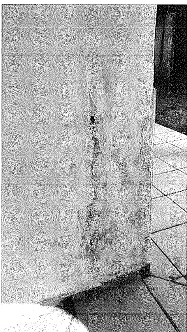
Figura 62 – Infiltração no corredor de acesso a quadra.
