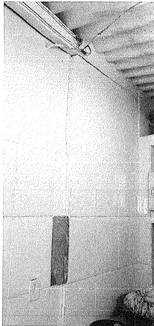
Figura 2 – Infiltração e falta de revestimento.
