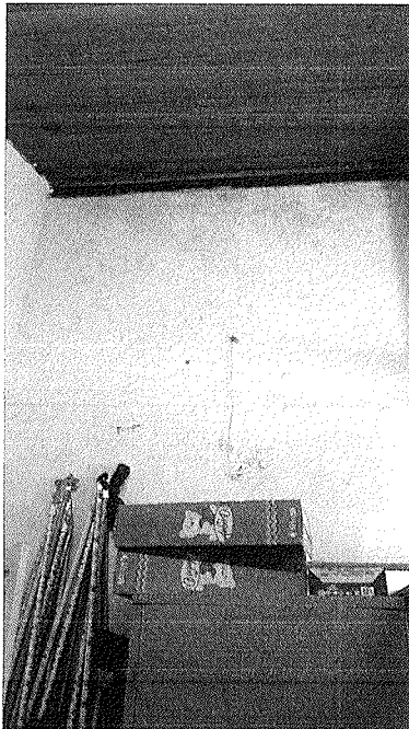
Figura 26 – Trincas e infiltração.
