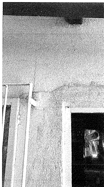
Figura 11 -Trincas superficiais.
