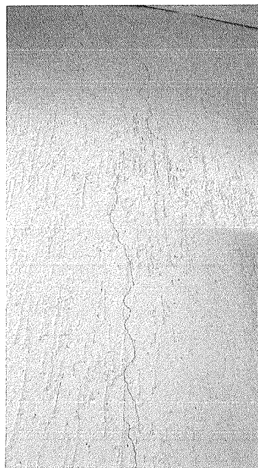
Figura 11 -Trincas superficiais.
