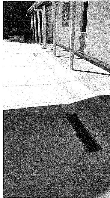
Figura 31 – Drenagem insuficiente.
