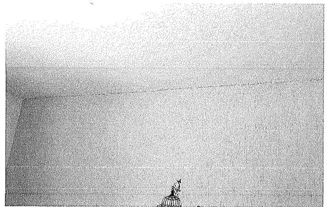
Figura 23 – Trinca.
