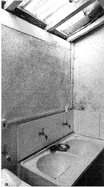
Figura 14 – Infiltração e trincas na lavanderia.
