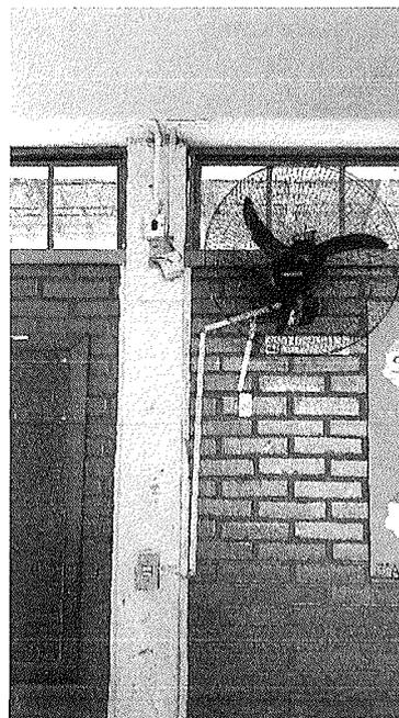
Figura 23 – Instalação elétrica provisória e precária.
