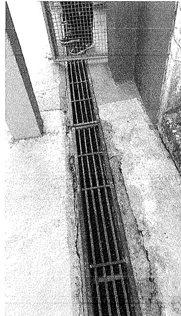
Figura 69 – Sistema de drenagem insuficiente.
