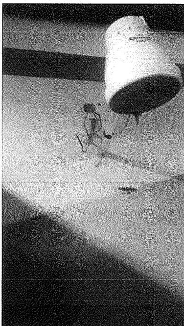
Figura 78 – Chuveiro com fiação exposta
