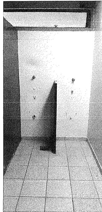
Figura 93 – Ponto de encanamento danificado
