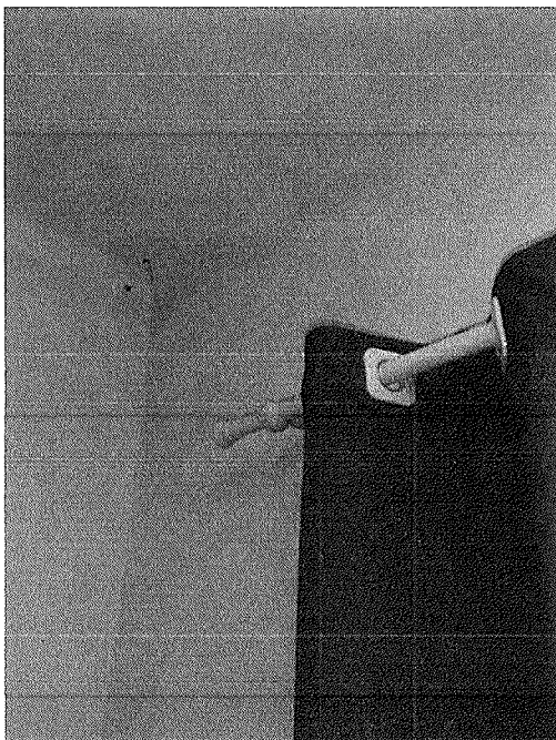
Figura 2 - Estufamento da pintura no teto
