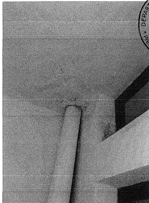
Figura 19 - Infiltração
