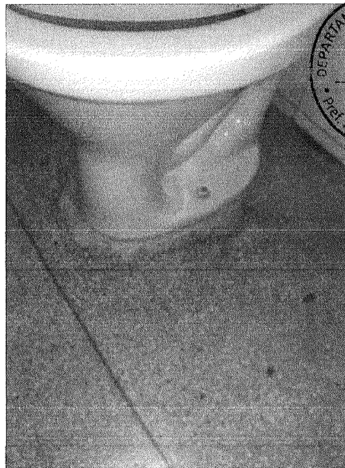
Figura 7 - Vaso sanitário apresenta vazamento
