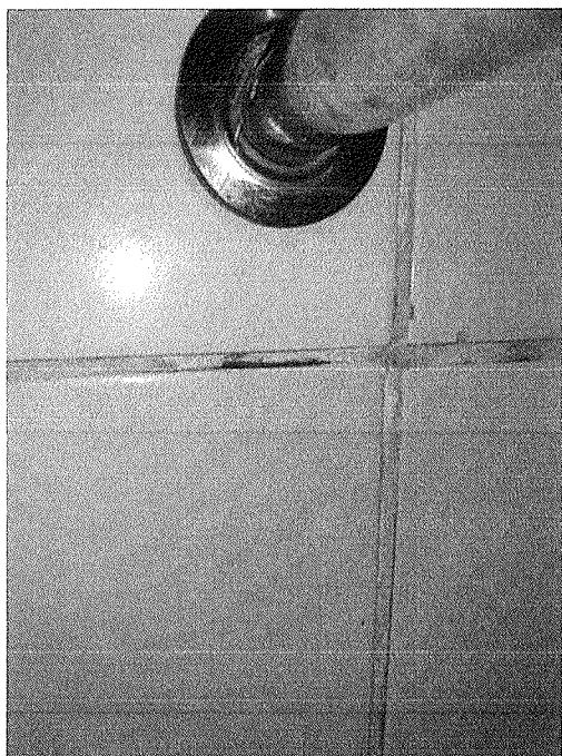
Figura 10 - Água escorre e aparece no outro lado da parede
