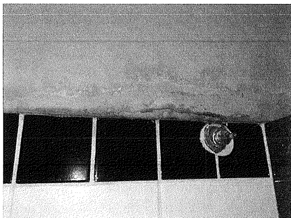
Figura 10 - Água escorre e aparece no outro lado da parede
