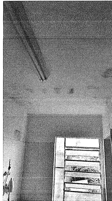
Figura 23 - Infiltração na laje e parede no anexo da sala do berçário 1
