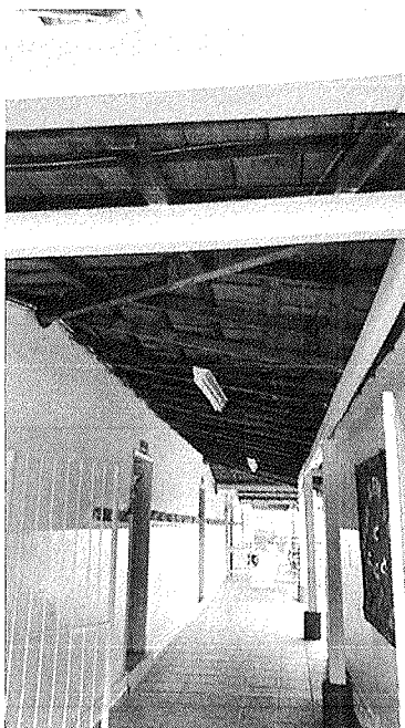
Figura 2 - Telhado do corredor de entrada
