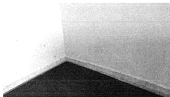
Figura 27 - Umidade por capilaridade com descolamento do revestimento cerâmico na sala do Lactário
