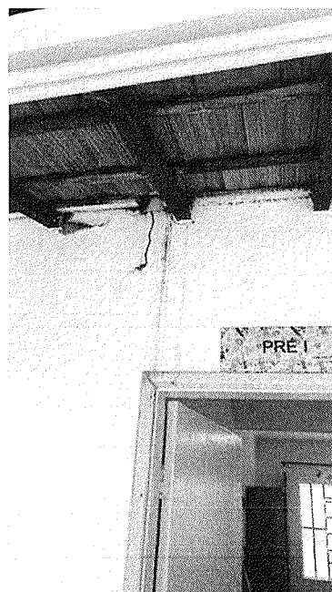
Figura 7 - Infiltração decorrentes a falta de rufo. Porta de acesso ao pátio, área externa
