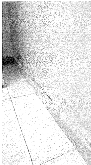
Figura 27 - Umidade por capilaridade com descolamento do revestimento cerâmico na sala do Lactário
