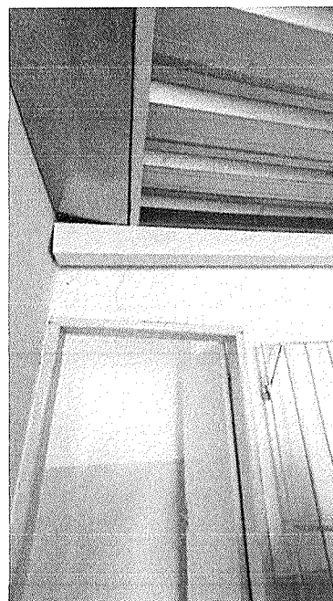
Figura 7 - Infiltração decorrentes a falta de rufo. Porta de acesso ao pátio, área externa
