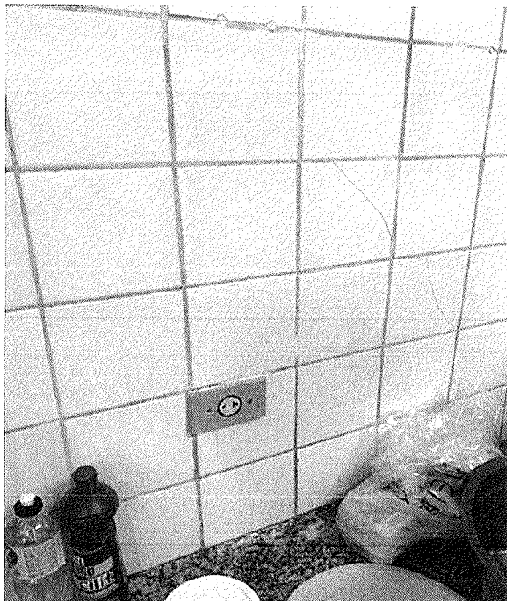
Figura 12 - Azulejo trincado
