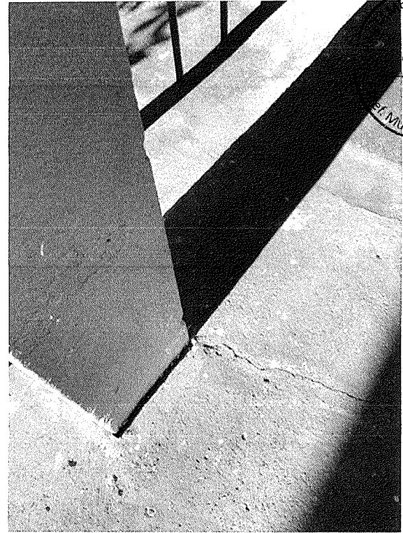
Figura 31 - Trinca no passeio
