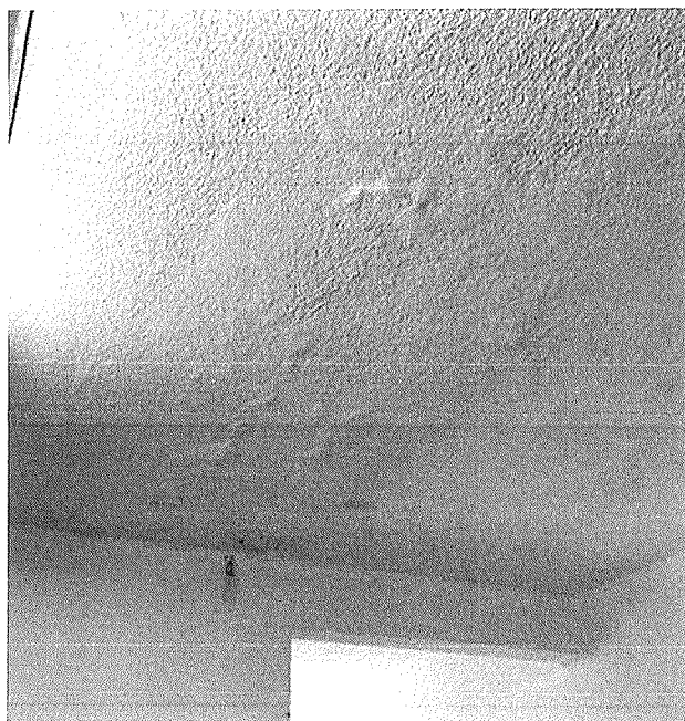
Figura 2 - Laje com infiltração
