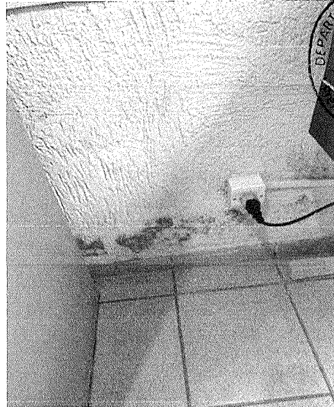
Figura 19 - Umidade na parede
