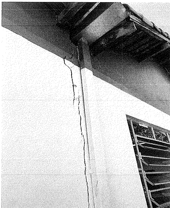
Figura 26 - Trinca no forro da sala de arquivos de licitação
