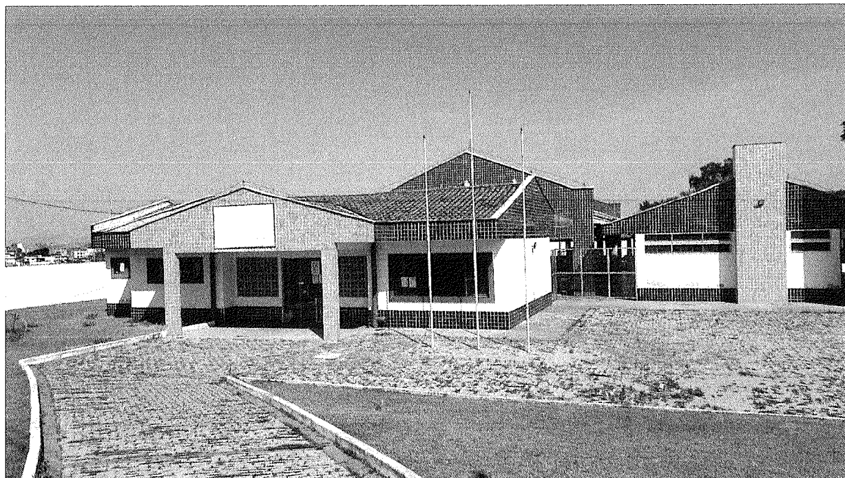
Figura 1 – Fachada: CEIM Maria de Paiva
