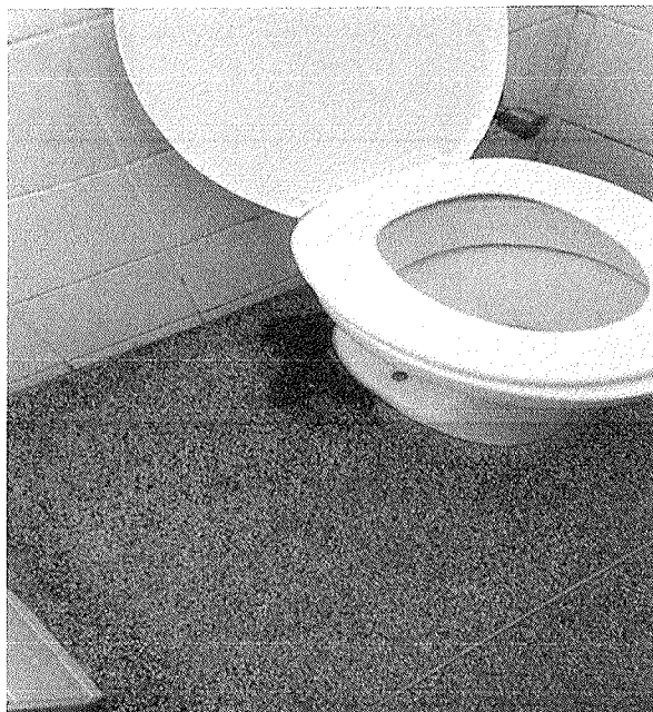
Figura 10 - Vazamento
