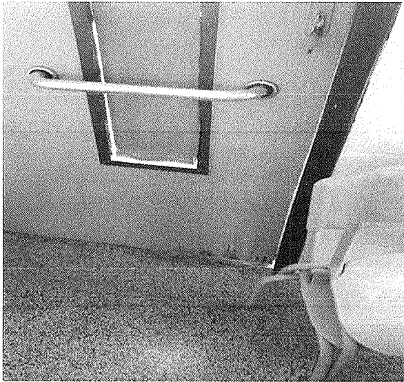
Figura 6 - Descolamento da pintura, banheiro para deficiente
