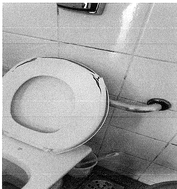
Figura 11 - Trinca no banheiro, sala 14
