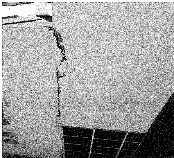
Figura 15 - Trinca no banheiro, sala 14
