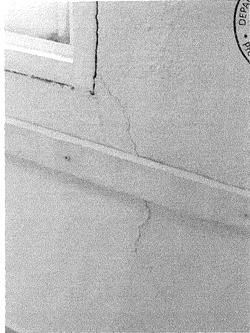
Figura 11 - Trinca na parede da sala dos funcionários
