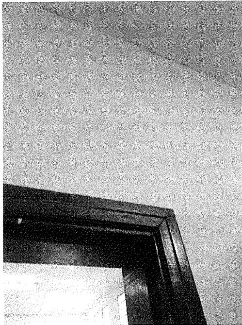
Figura 30 - Trincas na parte superior da porta do maternal 2
