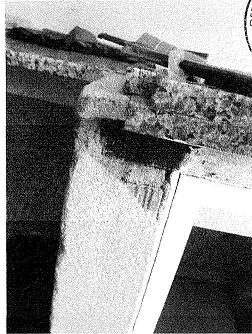
Figura 19 - Reboco danificado na pia da banheira no berçário 2
