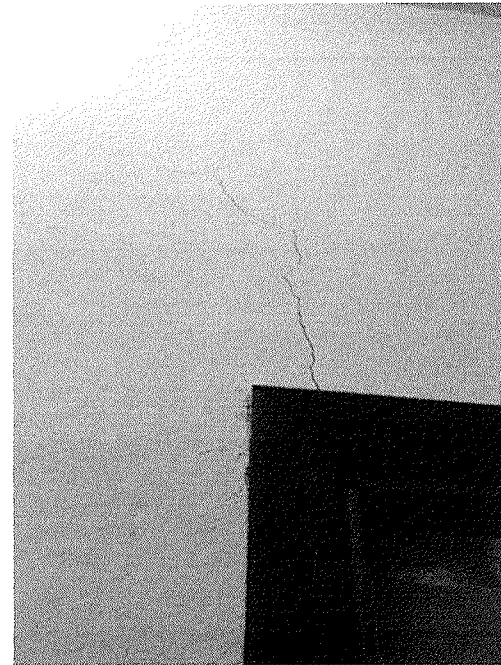
Figura 3 - Trinca na parede
