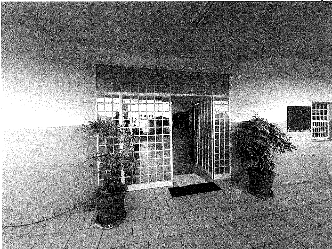
Figura 1 – Fachada: CEIM Ismênia Vitta Reis
