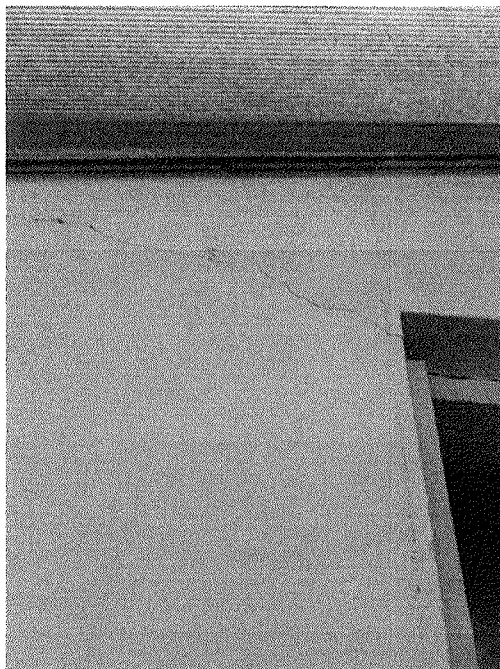
Figura 34 - Trinca no revestimento do refeitório
