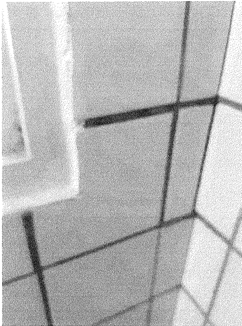
Figura 34 - Trinca no revestimento do refeitório
