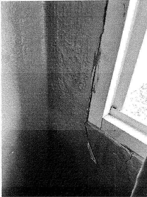
Figura 18 - Trinca que se estende pela lateral da janela na sala do berçário 2
