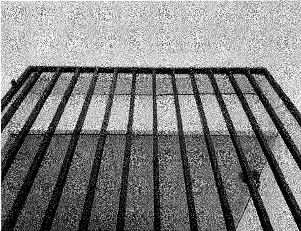
Figura 22 - Trinca na parede superior do forro
