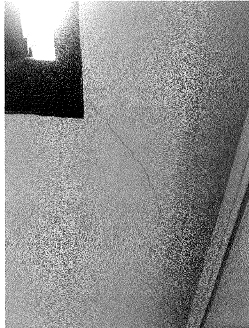
Figura 3 - Trinca horizontal no hall de entrada da escola
