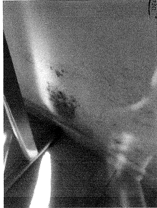
Figura 15 - Infiltração na párede da sala maternal 1
