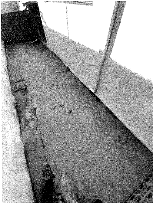
Figura 10 - Trinca no peitoril da janela da sala maternal 2, área externa
