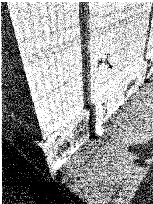
Figura 26 - Porta com quinas quebradas e infiltrações no pátio
