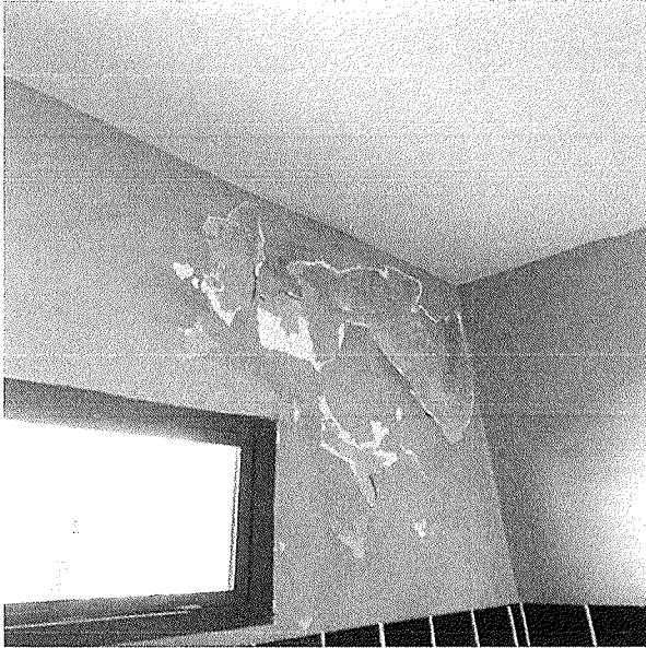
Figura 2 - Infiltração na laje
