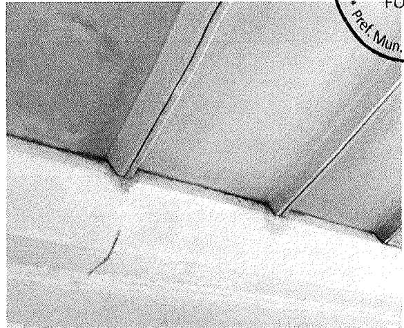
Figura 3 - infiltração na laje
