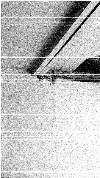
Figura 2 – Fiação exposta.
